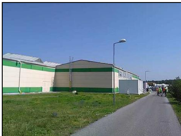
Stávající hala, v č. venkovních chladičů s protihlukovým opatřením.
