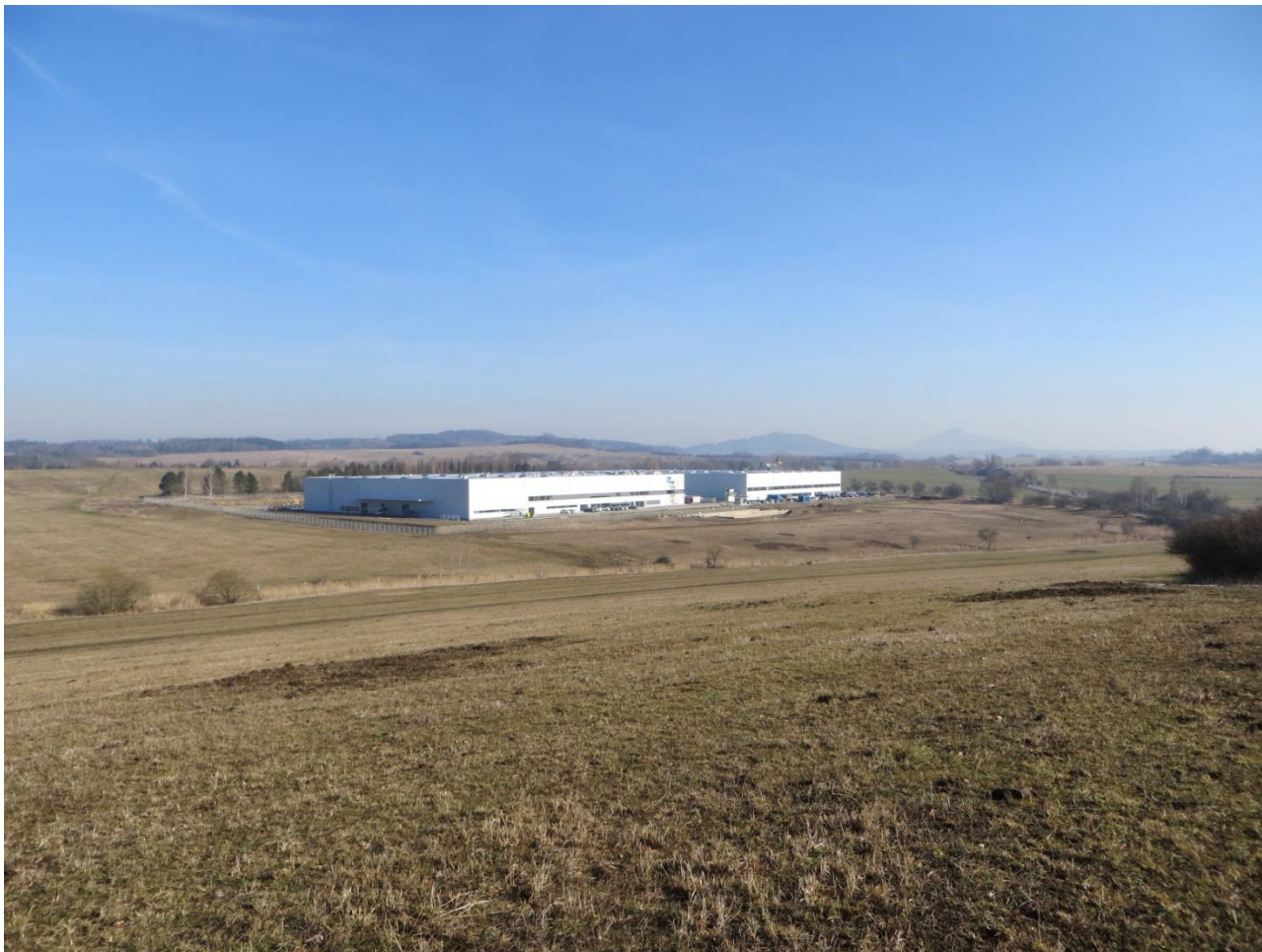
Obr. 11 Pohled na průmyslový areál CTPark Česká Lípa – haly CEL1 a CEL2 východním směrem
