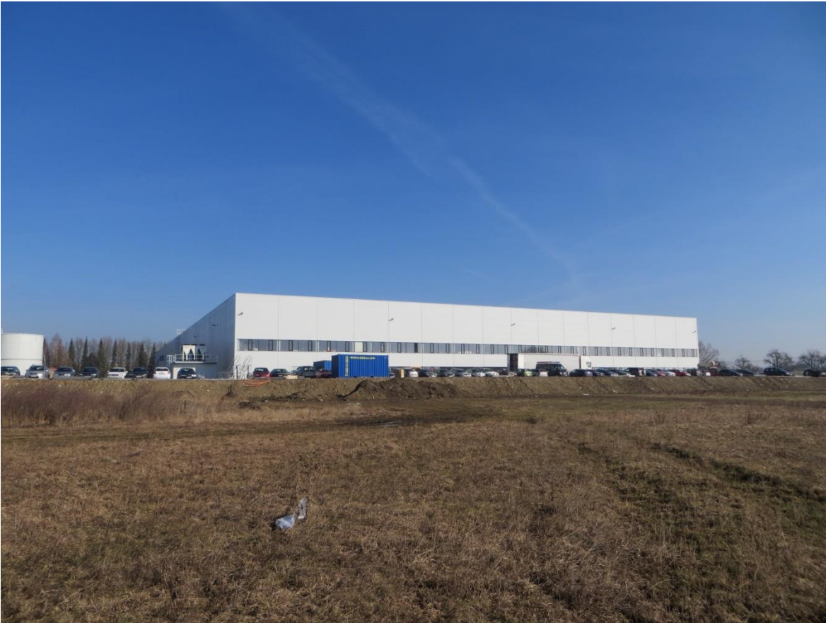
Obr. 12 Pohled severovýchodním směrem na stávající halu CEL2
