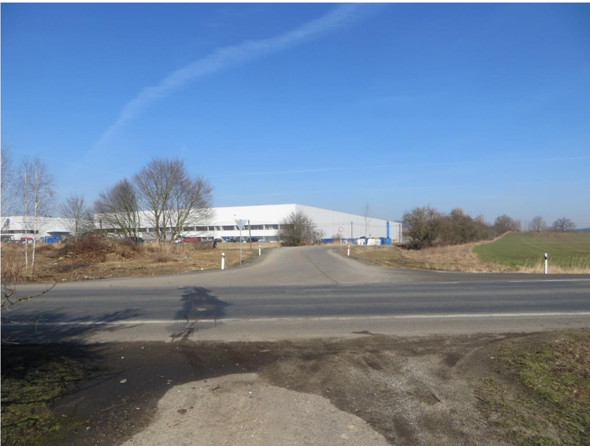
Obr. 13 Napojení místní komunikace na silnici II/262, v pozadí hala CEL2
