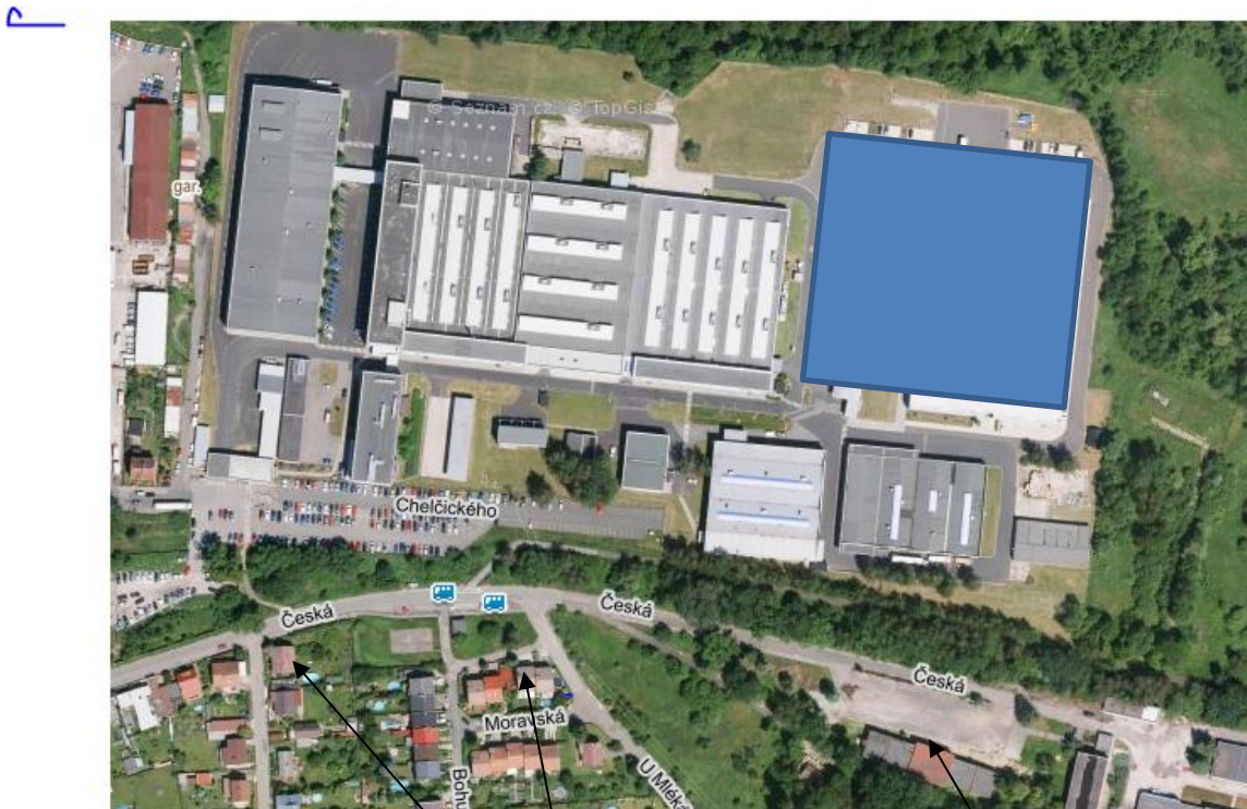
Obrázek č. 20: nejbližší obytná zástavba a ubytovna (vpravo)
