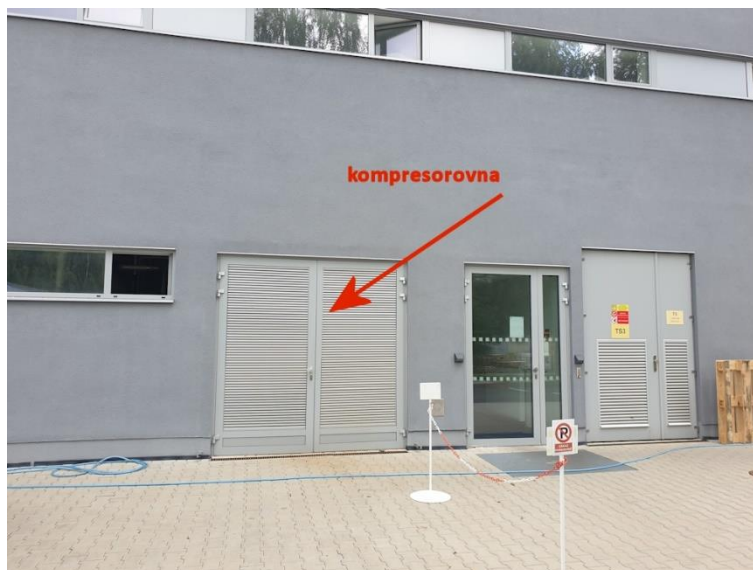
Obr. č. 3 Vrata kompresorovny
