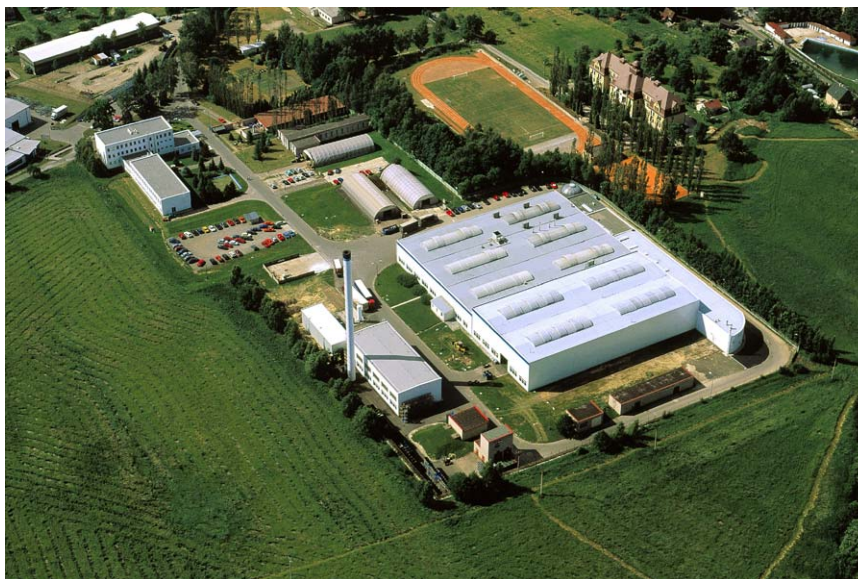
obrázek 3 – letecký pohled na původní tovární halu
