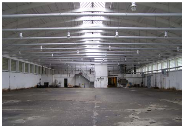
Obr. 3 Pohled do budoucí výrobní haly
