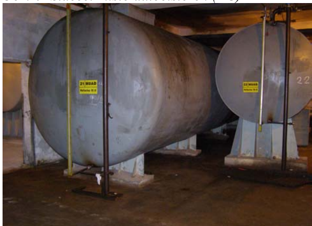
Obr. 6 Stávající skladovací zásobníky v 1. PP
