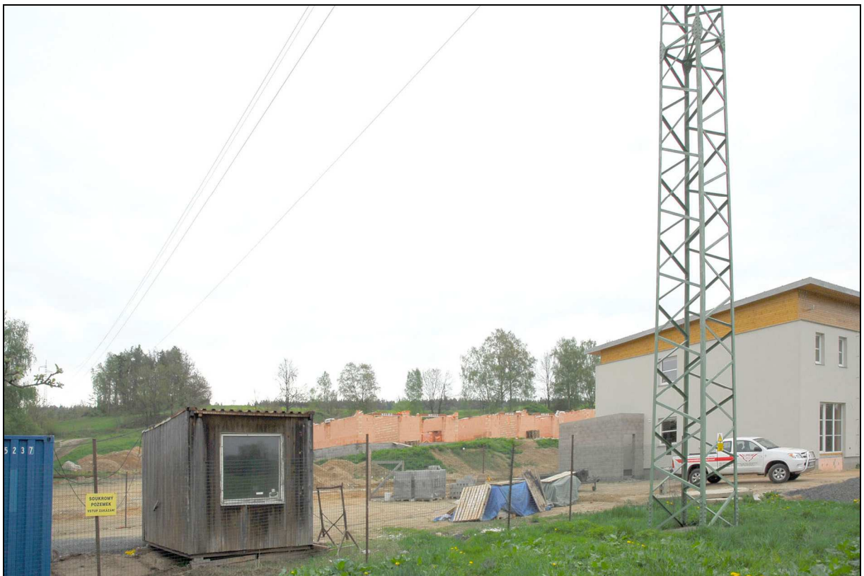
Výstavba rodinných domů v blízkosti trasy VVN, která bude demontována
