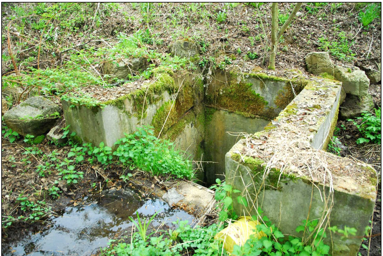
Šachta pro zatrubnění rybníčka pod skládkou
