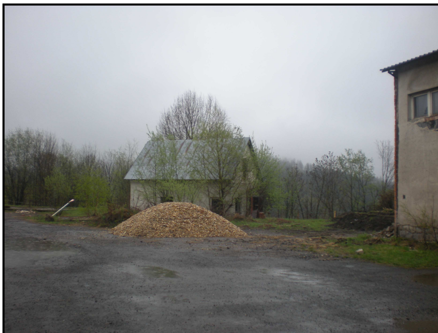
Obrázek č. 4: Objekt k demolici ve východní části areálu
