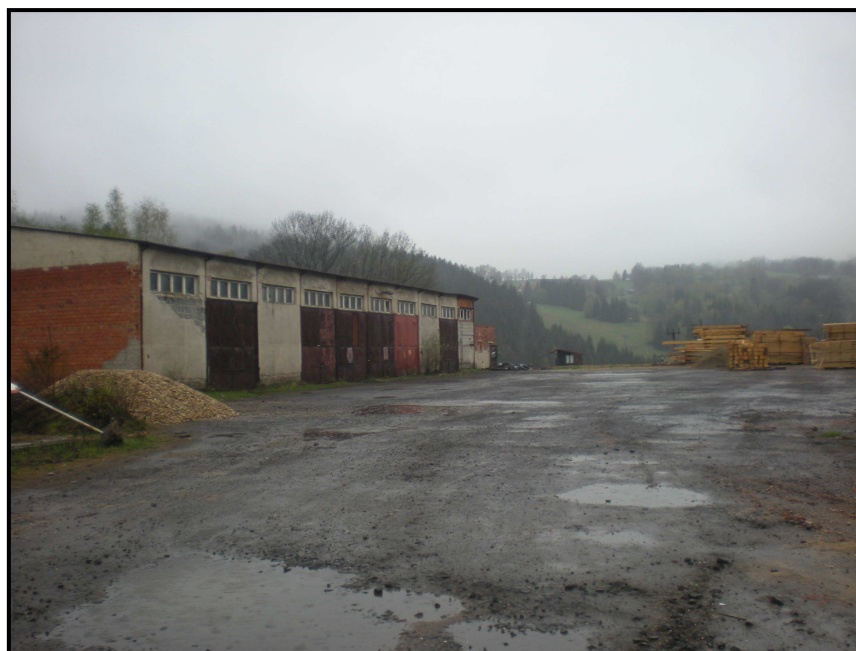
Obrázek č. 3: Objekt k demolici v jižní části areálu (sklady a úschovna zem. strojů)
