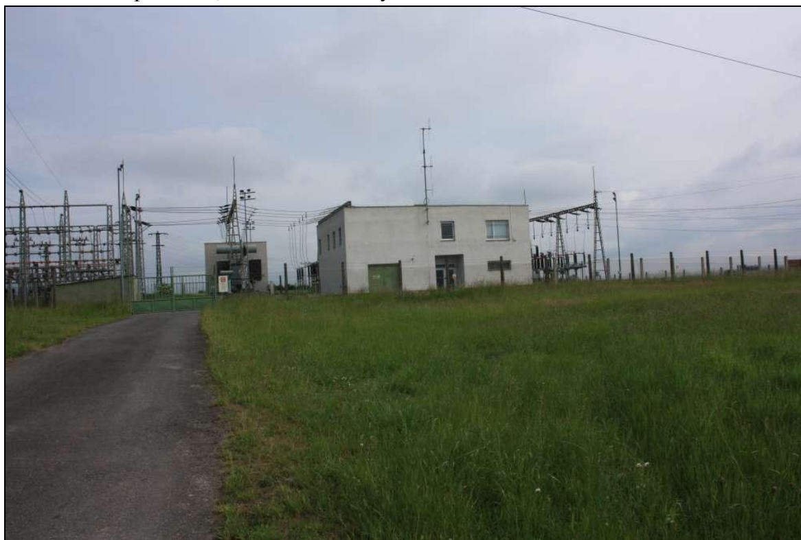
Stávající rozvodna v Hrádku nad Nisou – zde bude trasa kabele připojena
