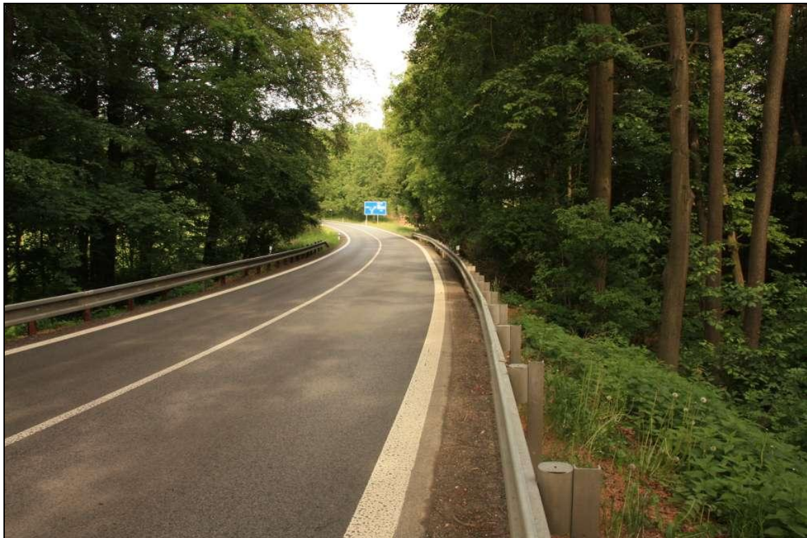
Komunikace, podél které bude vedena kabelová trasa
