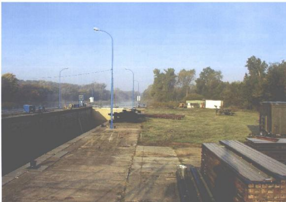
Manipulační plochy na pravém břehu u plavební komory
