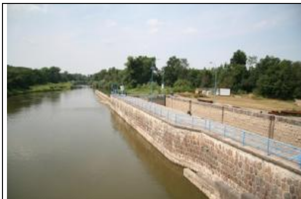
pohled na zájmovou lokalitu pravého břehu po proudu
