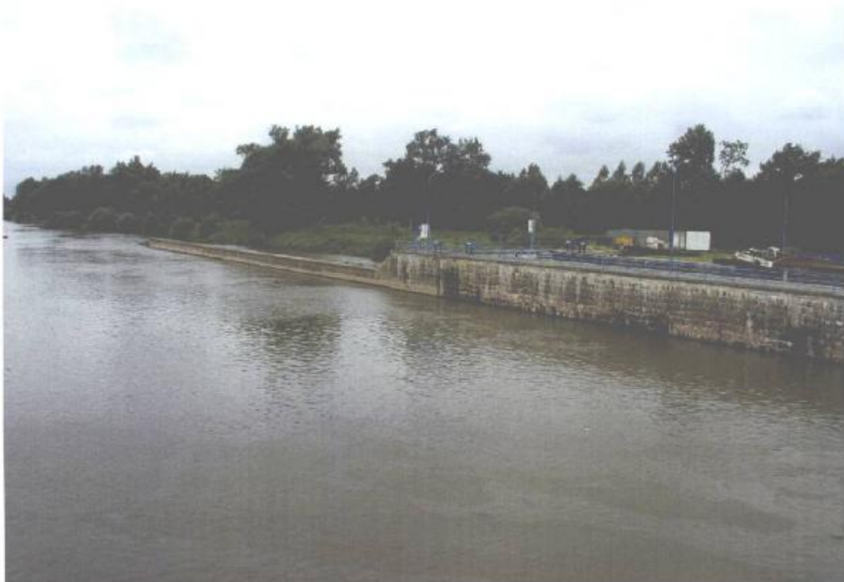
Plavební komora a dolní dělicí zeď - pohled od jezu
