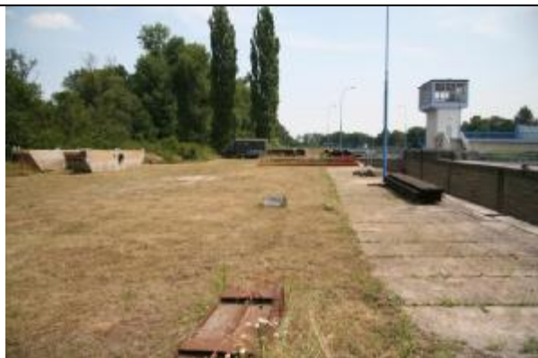
Dnešní stav ploch v pravobřežním oplocení areálu plavebního stupně Srnojedy
