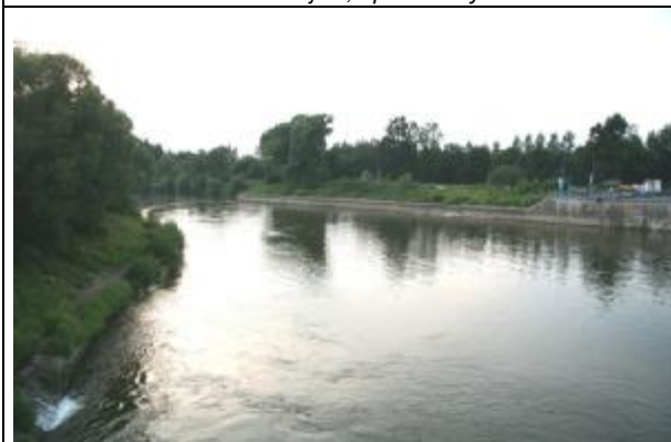
Celkový pohled na pravý břeh v podjezí, prostor úpravy břehu v kontextu úpravy vjezdu z plav. komory
