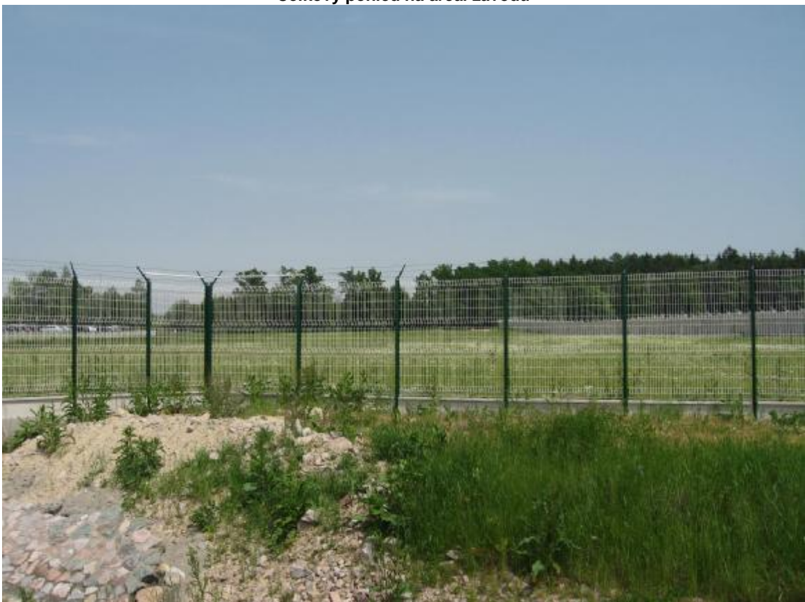
Pohled na prostor budoucí odstavné plochy pro hotové vozy
