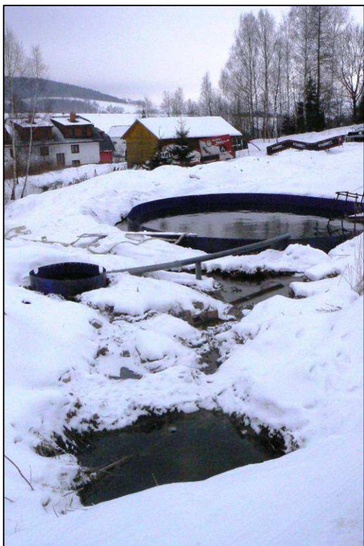
Obr. 2: Plechová nádrž v blízkosti záměru
