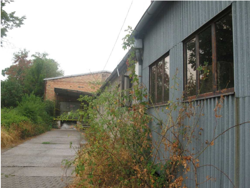
Obrázek č. 3: Nakládací rampa za přístavkem
