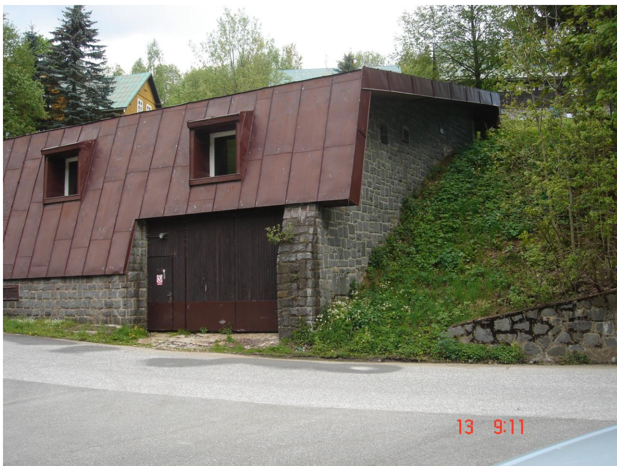
Obrázek č. 4 – Pohled na stávající objekt ČOV
