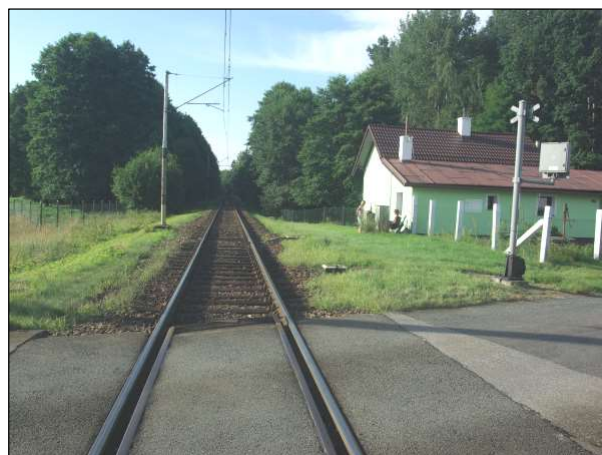
Bod 3, pohled na trať v místě měření
