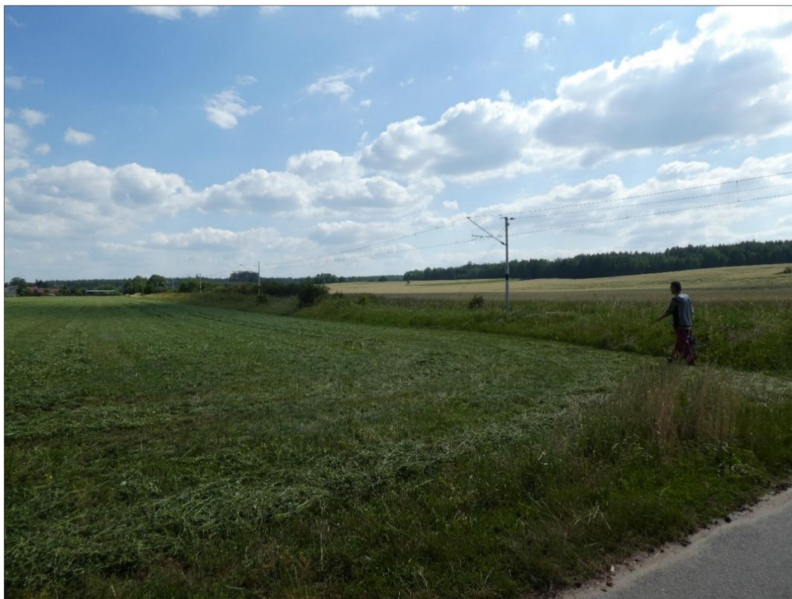
Obr. 17: Těleso železnice severně od Žďáru nad Orlicí (drážní km 19,8)
