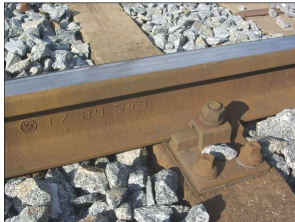
Detail železničního svršku, kolej S 49
