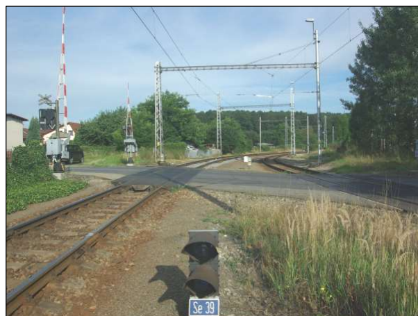
Bod 4, pohled na trať v místě měření
