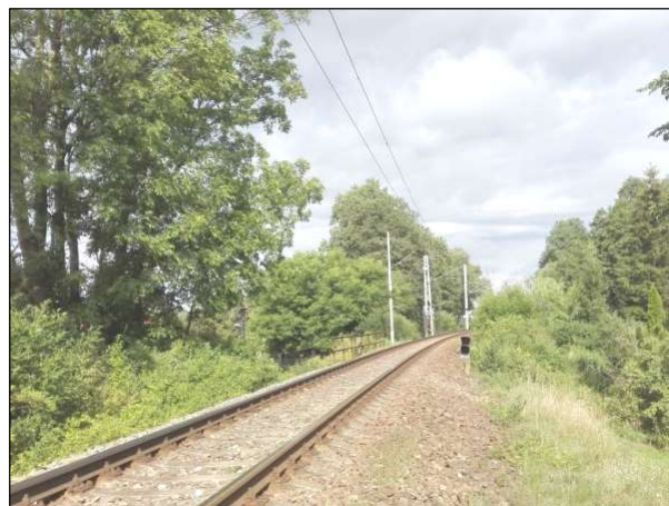
Bod 2, pohled na trať v místě měření
