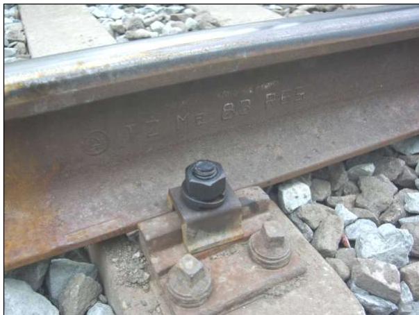
Detail železničního svršku, kolej R 65
