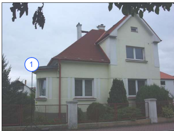
Bod 1, Týniště nad Orlicí, Sportovní 678
