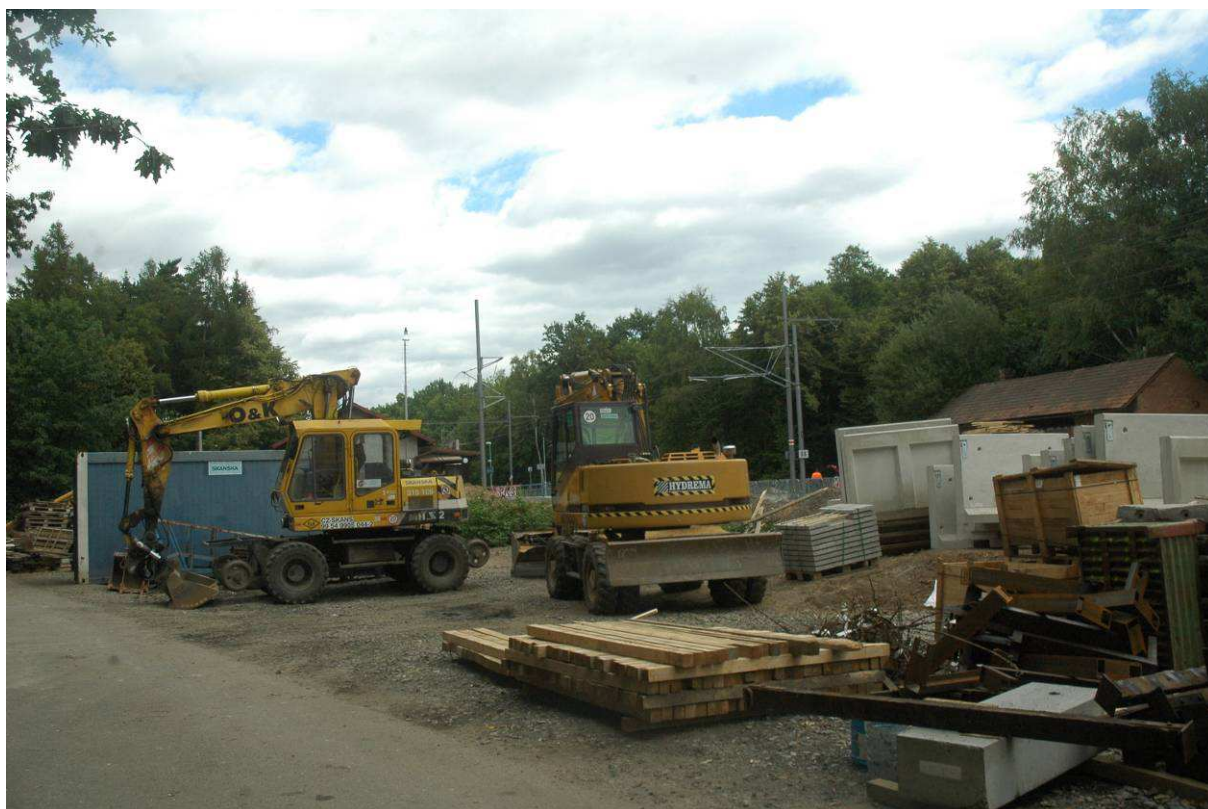
Železniční stanice Stéblová je v rekonstrukci, kabeláž je vedena od Rosic nad Labem po Stéblovou.
