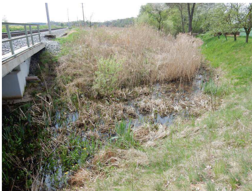
Obr.č.21 SO 32-34-04 Pardubice-Rosice nad Labem-Stéblová, železniční most ev. km 8,176 přes Velkou strouhu
