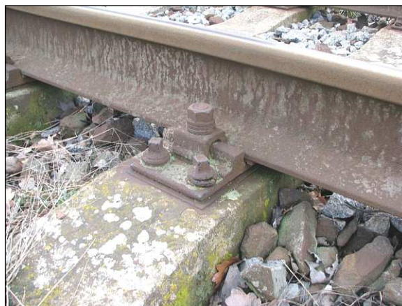
Detail železničního svršku (K) –vedlejší kolej
