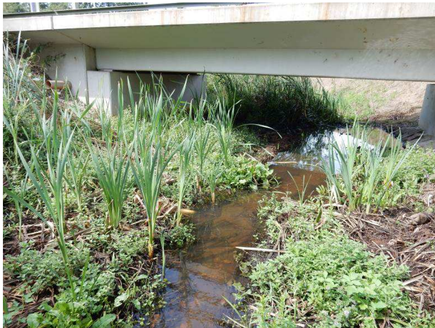
Obr.č.25 SO 32-34-04 Pardubice-Rosice nad Labem - Stéblová, železniční most ev. km 8,176 přes Velkou strouhu
