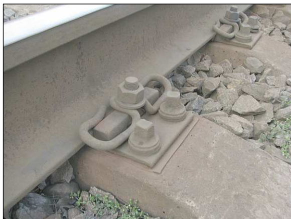
Detail železničního svršku (KS) – průjezdni kolej
