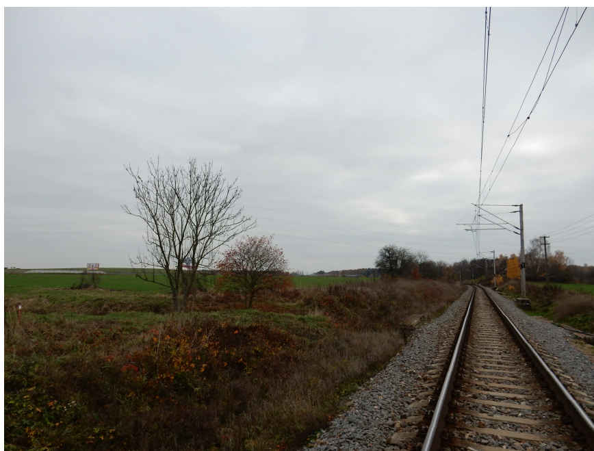
Obr.č.19 Stávající železniční propustek ev. km 7,857 přes vodoteč, v okolí dominuje orná půda
