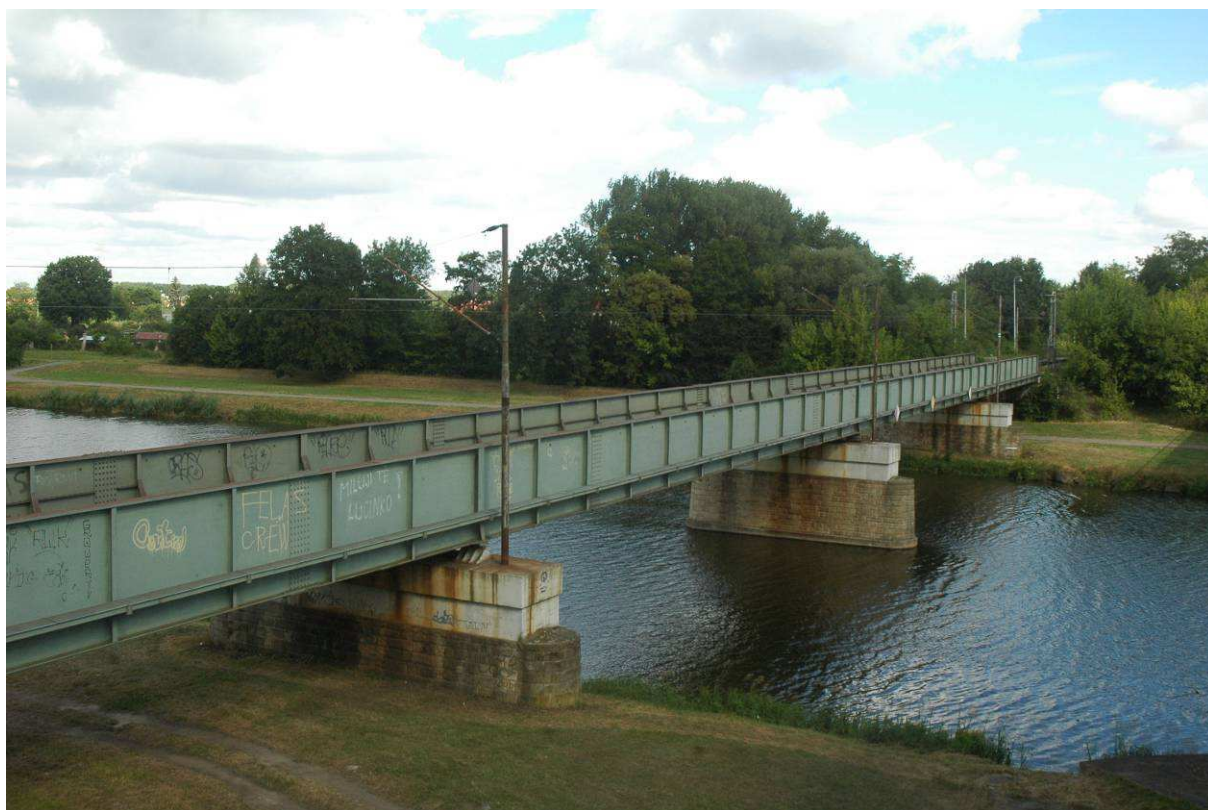
Přemostění Labe v Pardubicích.
