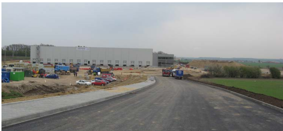
Areál CTParku Šlapanice, dokončovaná hala SA4, hala SA1 bude v pravé části areálu
