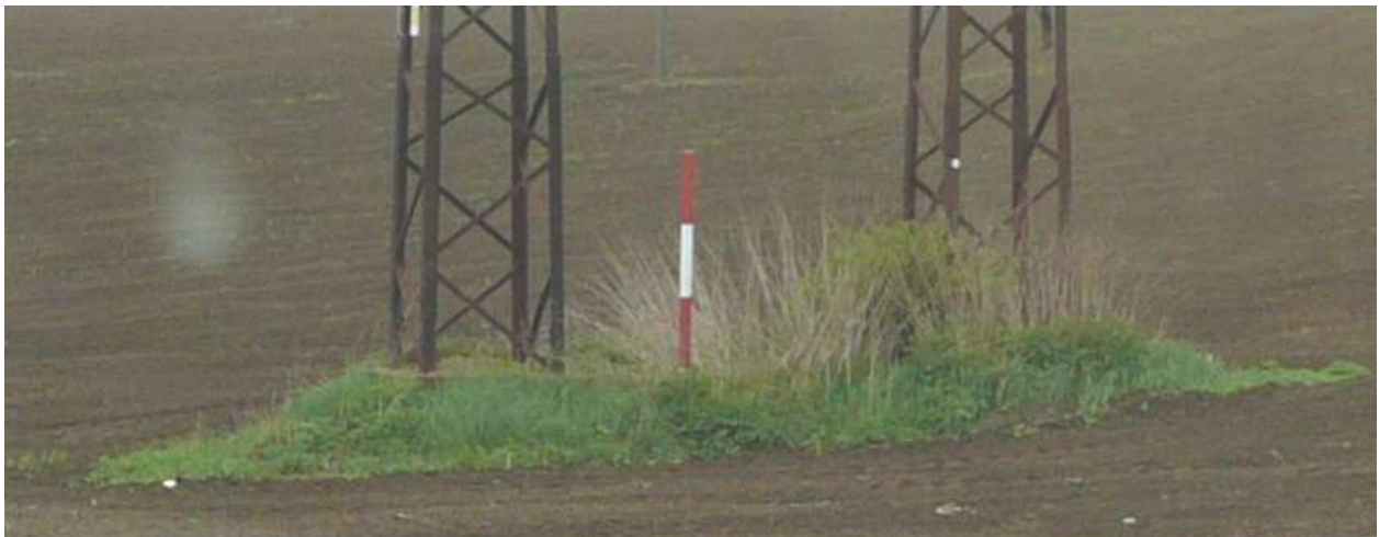
Obrázek č.5 Pohled na základy kotevního stožáru typ „sedlák“
