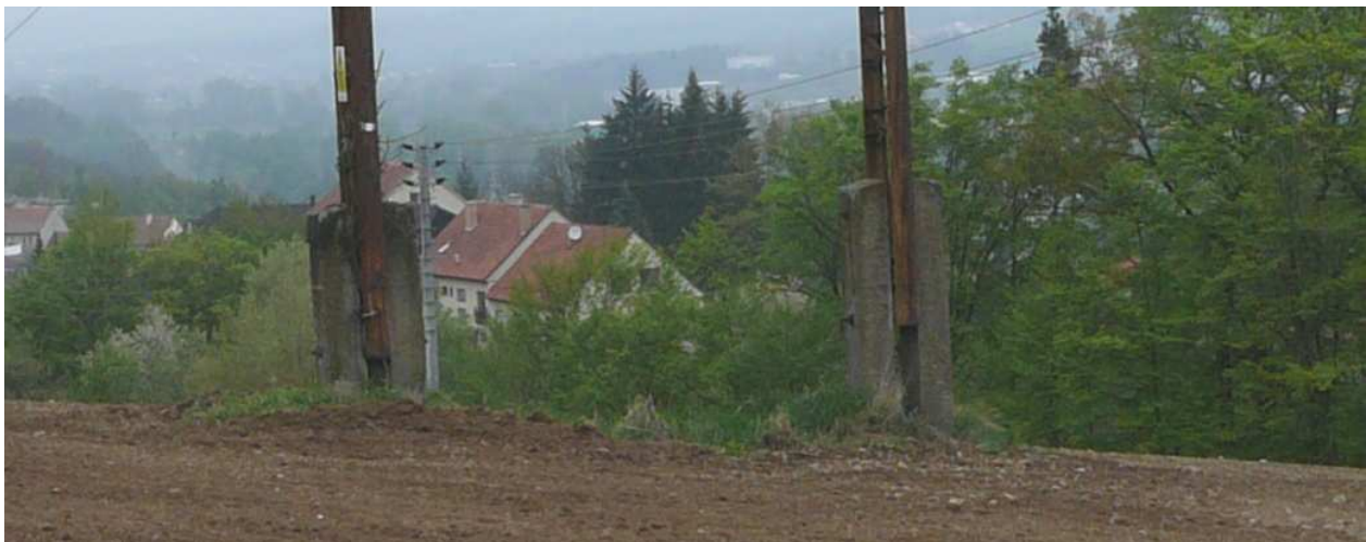
Obrázek č.6 Pohled na základy nosného stožáru typ „sedlák“
