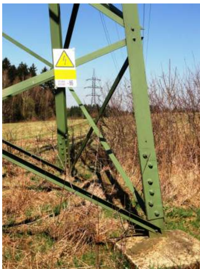
Obr. 7: Detail ukotvení stožáru č. 86
