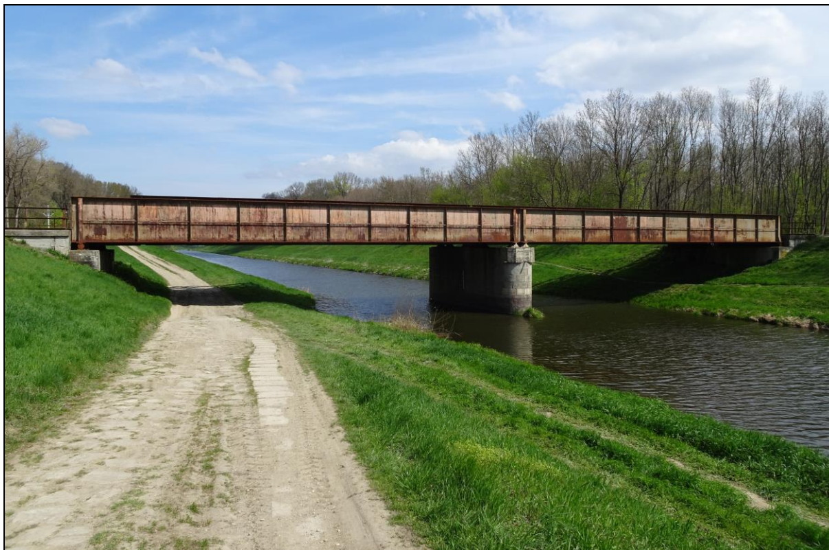
Obr. 16: Stávající železniční most přes Novou Moravu
