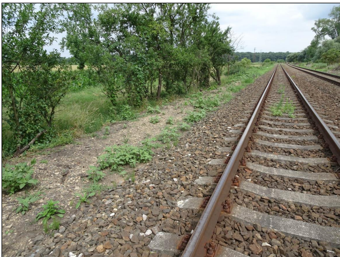
Obr. 7: Zapojování vegetace po výkopu kabelu; Bzenec – Veselí n. Moravou (14. 6. 2018)
