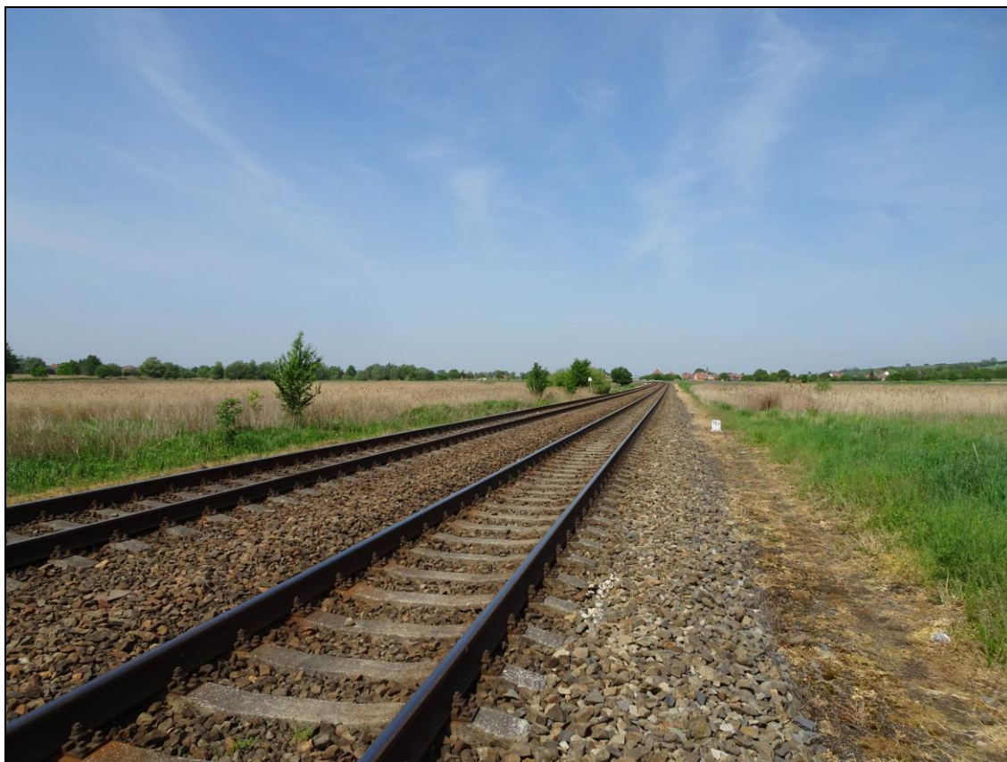
Obr. 4: Charakteristické okolí trati s rákosinami v úseku mezi Bzencem a Vracovem (3. 5. 2018)
