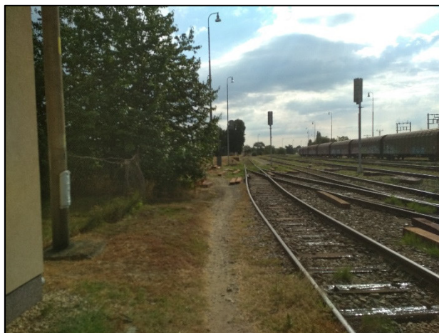
Obr. 6: Pohled ve směru kolejiště
