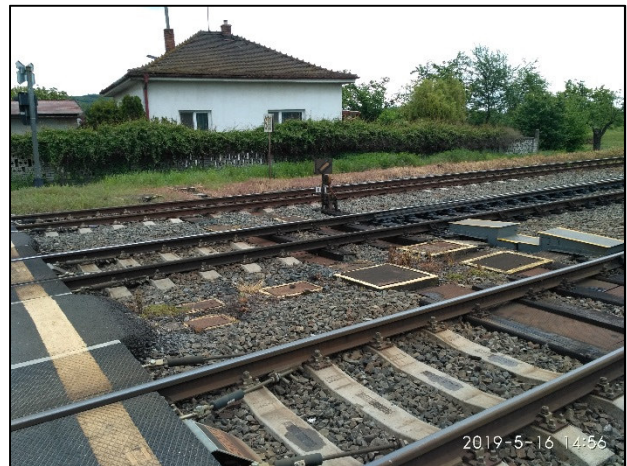
Obr. 7: Pohled na budovu od kolejí
