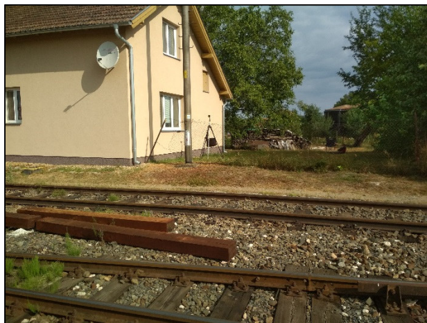
Obr. 5: Pohled na budovu od kolejí
