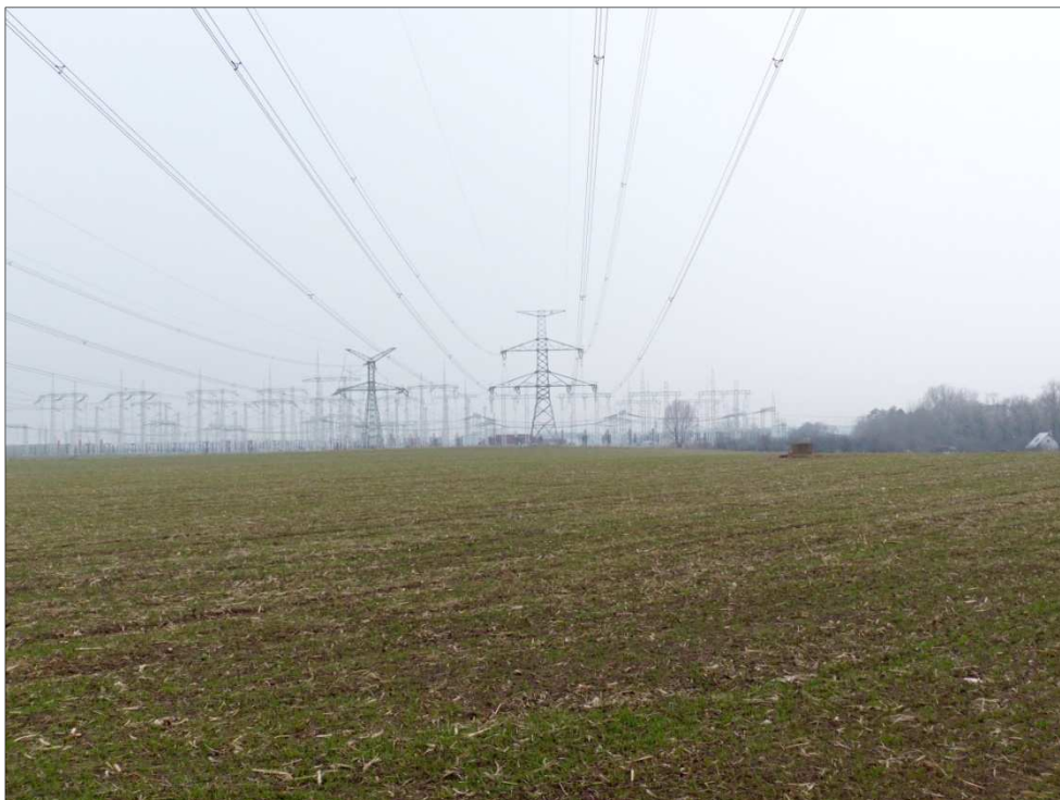
Obr. 15 Pohled na lomový bod R28 a budoucí nové zaústění dvojitého vedení V417/817 do TR Sokolnice, (v popředí uprostřed stávající stožár č. 275 stávajícího vedení V417/424, ve směru vedení)
