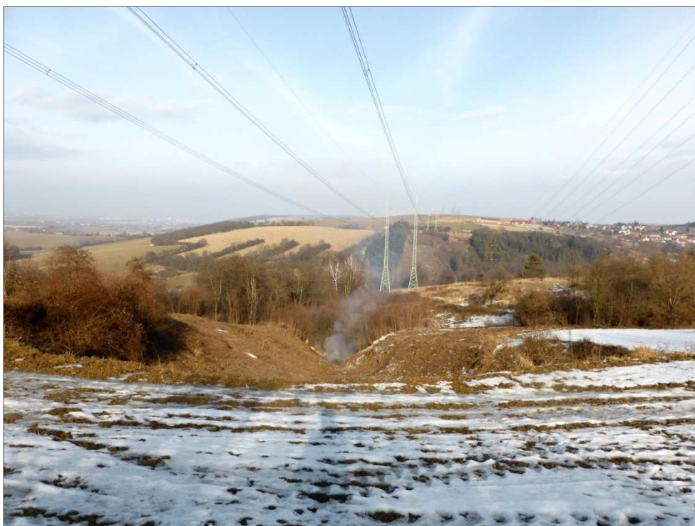
Obr. 7 Pohled na přírodní památku Včelín, která se nachází mezi stožáry č. 61 - 62 (v popředí stávající stožár č. 132 stávajícího vedení V417, proti směru vedení)
