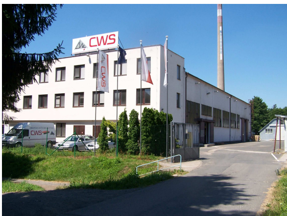
Obr. 3 Pohled na výrobní halu s administrativní přístavbou (JV strana)
