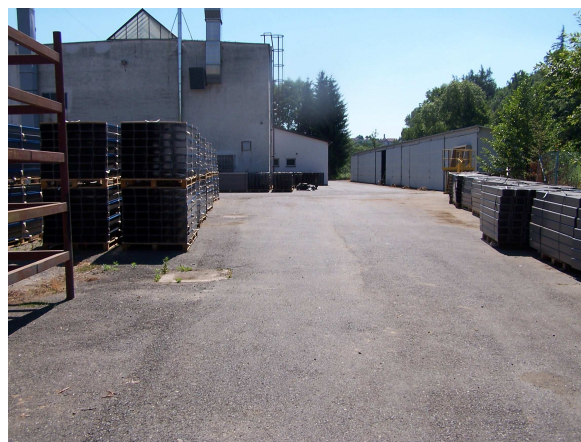
Obr. 4 Pohled na výrobní halu ze strany od řeky (JZ strana)
