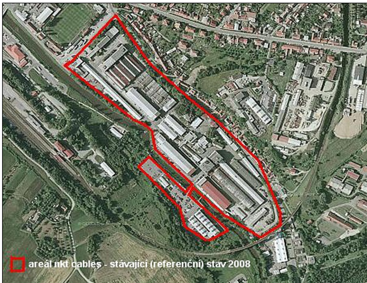
Obrázek 2. Areál nkt cables – rozsah v referenčním roce (2008)
