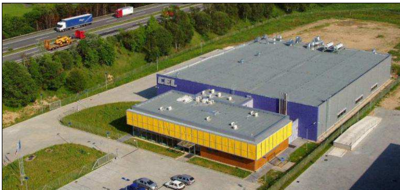
Obrázek č. 4: Pohled na objekt HALA 2 MAYO
