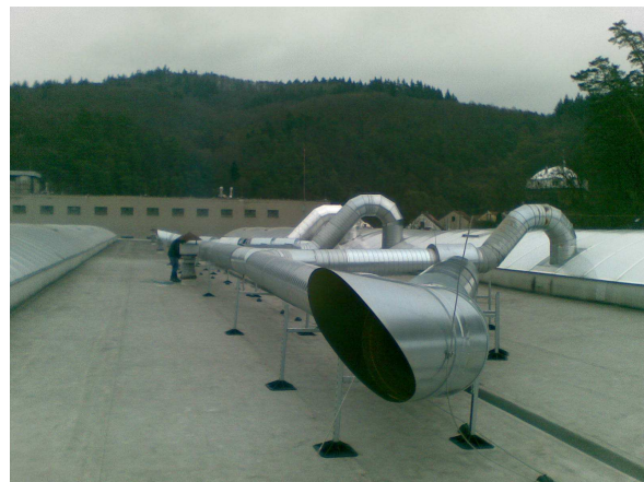
Obr. 11 – Odsávací potrubí od vypalování PP s přísáváním vzduchu pro eliminaci pachových látek – stav po úpravách v r. 2010
