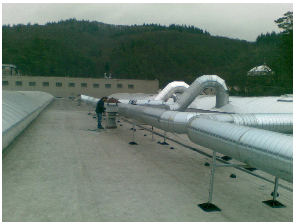
Obr. 11 – Odsávací potrubí od vypalování PP s přísáváním vzduchu pro eliminaci pachových látek – stav po úpravách v r. 2010
