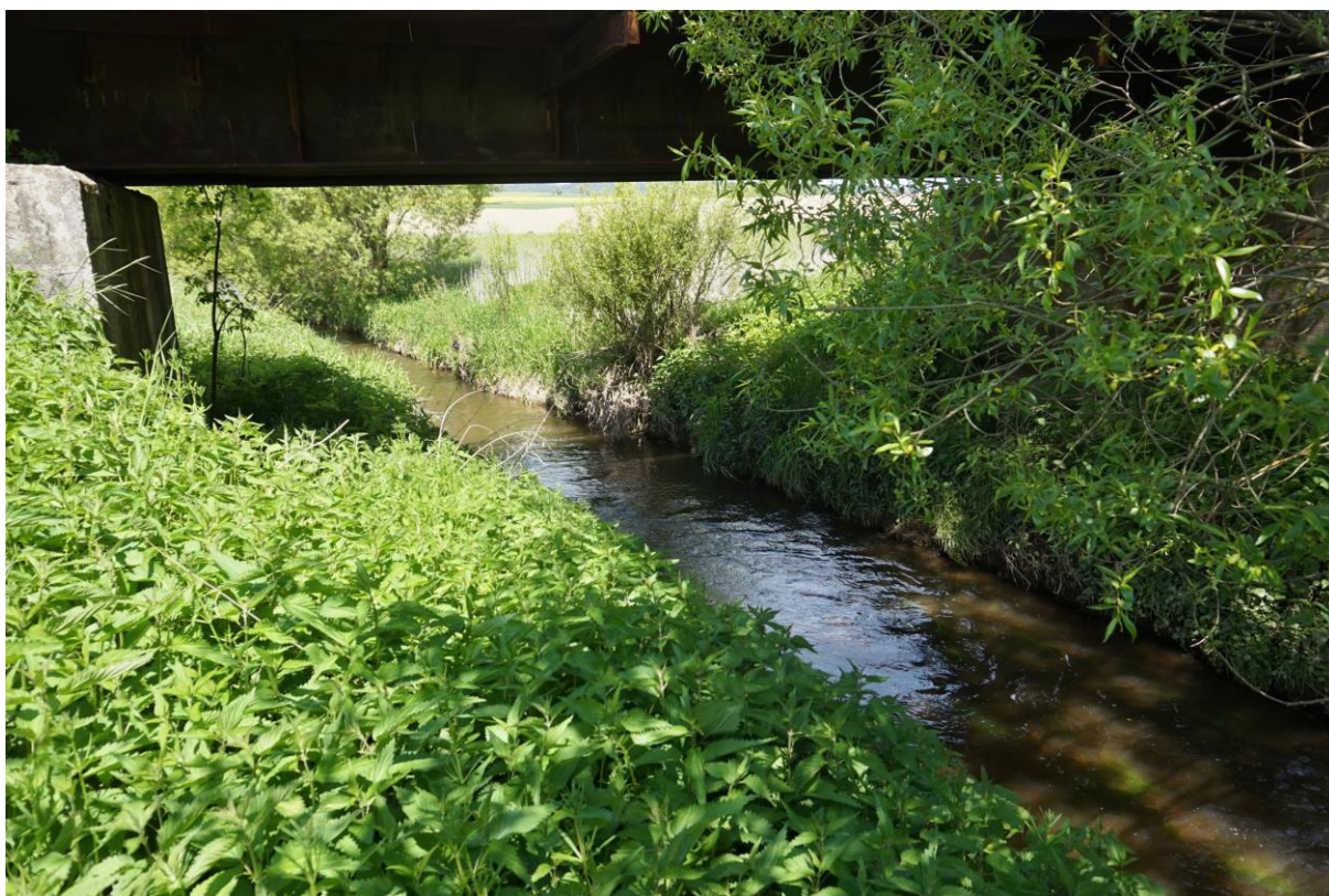
Obr. 4: Železniční most přes potok Rohozná (2. 6. 2021)
