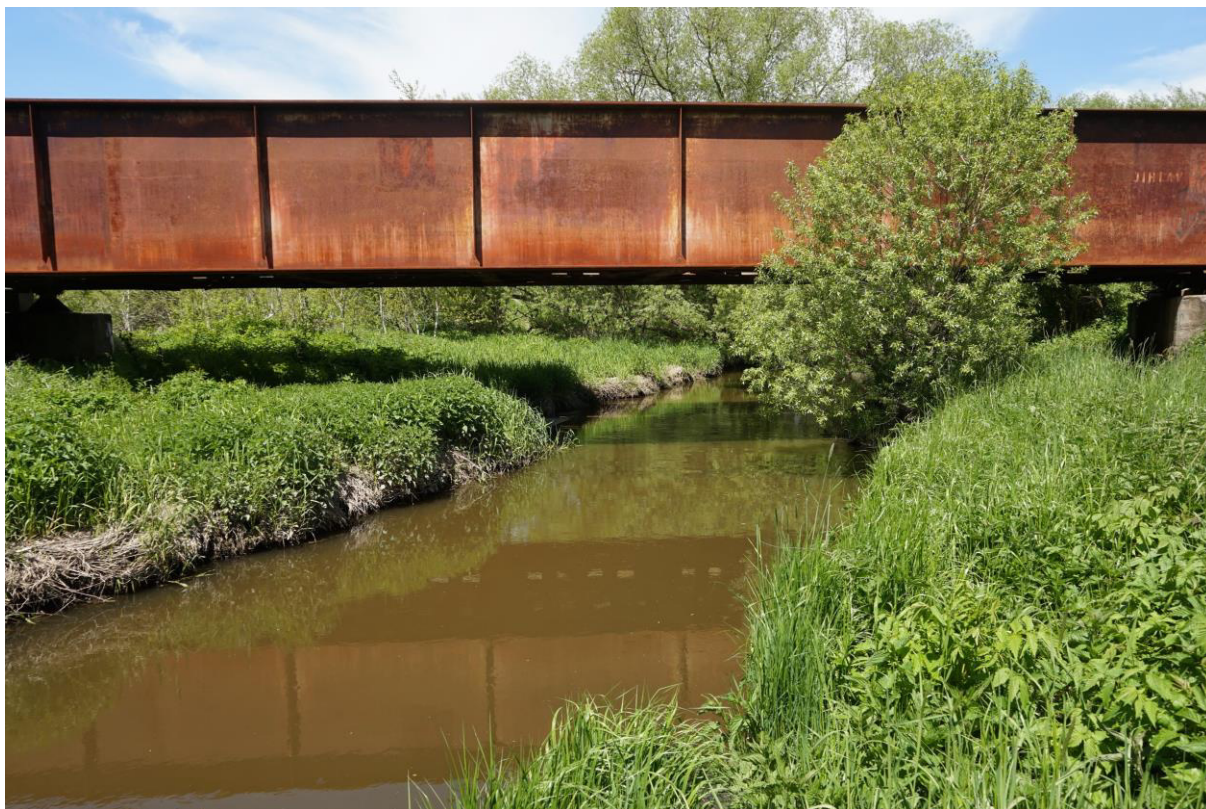
Obr. 2: Železniční most přes Jihlavu u Dolní Cerekve (2. 6. 2021)
