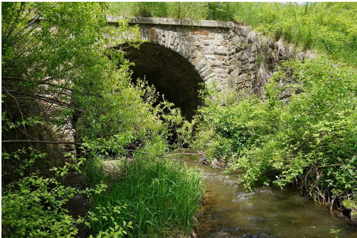
Obr. 3: Železniční most přes Hraniční potok (2. 6. 2021)
