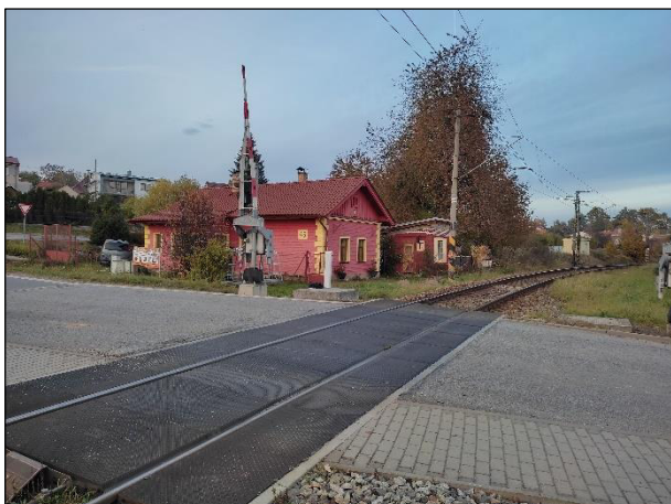
Obr. 4: Pohled na měřený objekt
