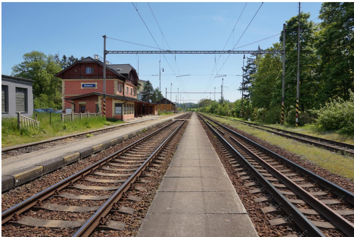
Obr. 5: Výpravní budova v žst. Batelov (2. 6. 2021)
