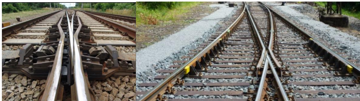
Obrázek 12 Srdcovka s pohyblivými hroty a klasická srdcovka se žlábkem
