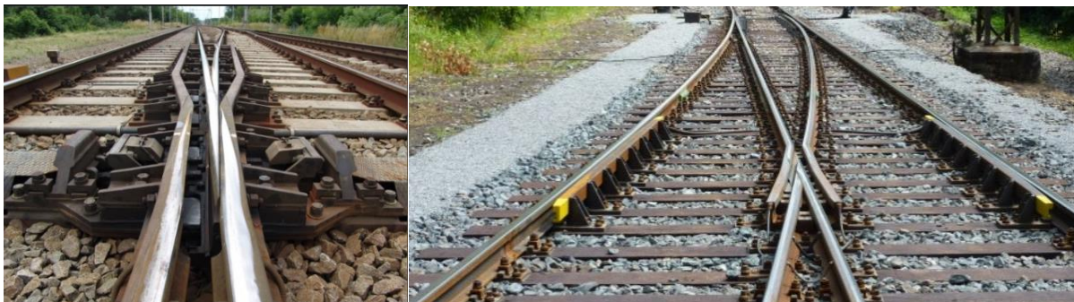
Obrázek 10 Srdcovka s pohyblivými hroty a klasická srdcovka se žlábkem
