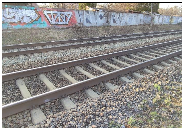
Obr. 5: Pohled na železnici před místem měření
