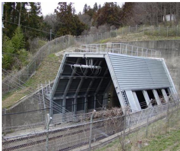
Obr. 4: Příklad „vstupního“ tunelového krytu na dvojkolejně trati, Japonsko.
