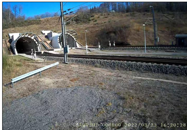
Obr. 4: Pohled směrem ke kolejišti
