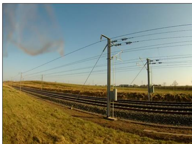
Obr. 5: Pohled na železnici před místem měření
