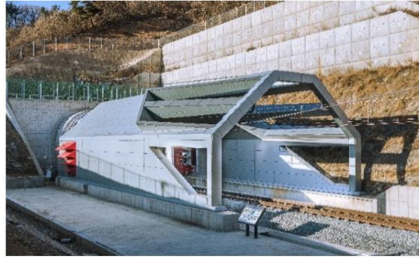
Obr. 1: Vstupní portál pro jednokolejnou trať (Kim et al. 2021)
