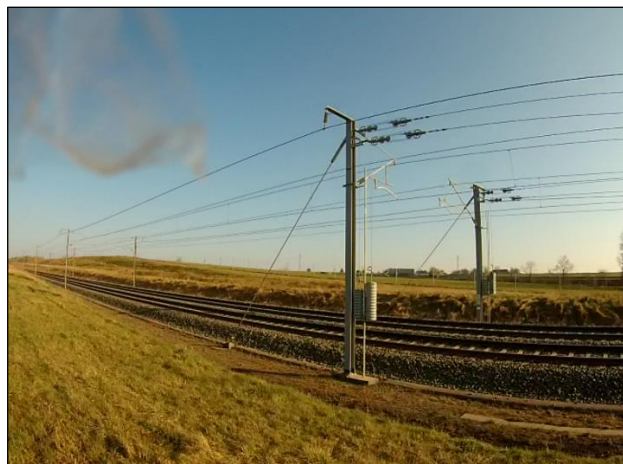
Obr. 7: Pohled směrem ke kolejišti
