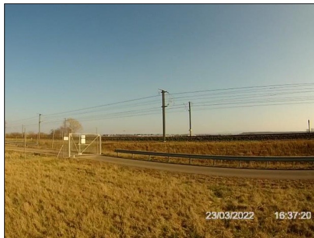
Obr. 10: Pohled směrem ke kolejišti
