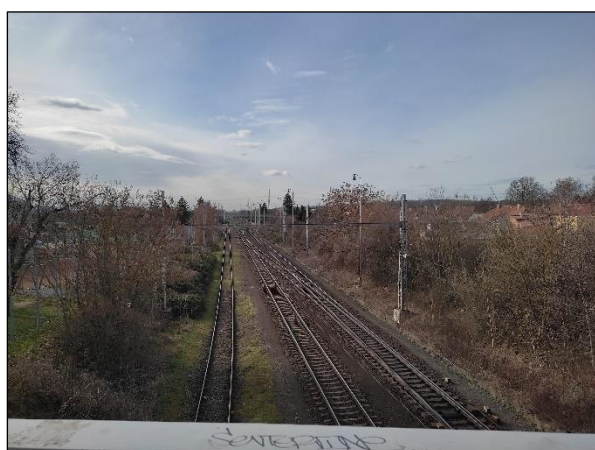
Obr. 7: Pohled na trať před objektem
