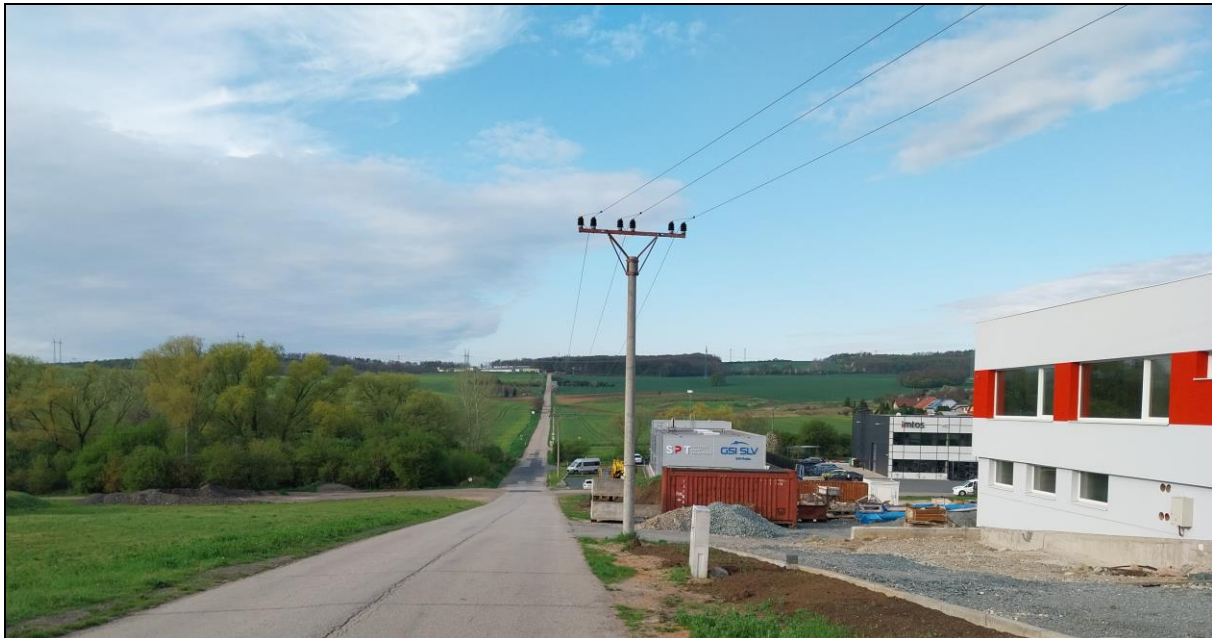
Obr. 54: Pohled na západní část Moravan, resp. hranici KP, zřejmý stoupající reliéf a větší množství dřevinné vegetace, vpravo patrné velké průmyslové areály, za nimi nepůvodní zástavba, v popředí velké bloky zemědělské půdy a antropogenní prvky s negativním projevem (stožáry el. vedení)
