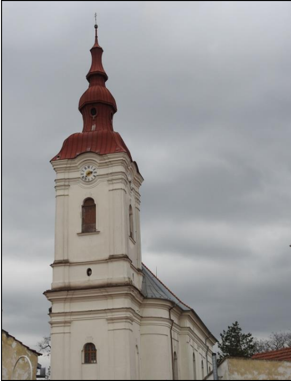
Obr. 13: Kostel sv. Gotharda v Modřicích
