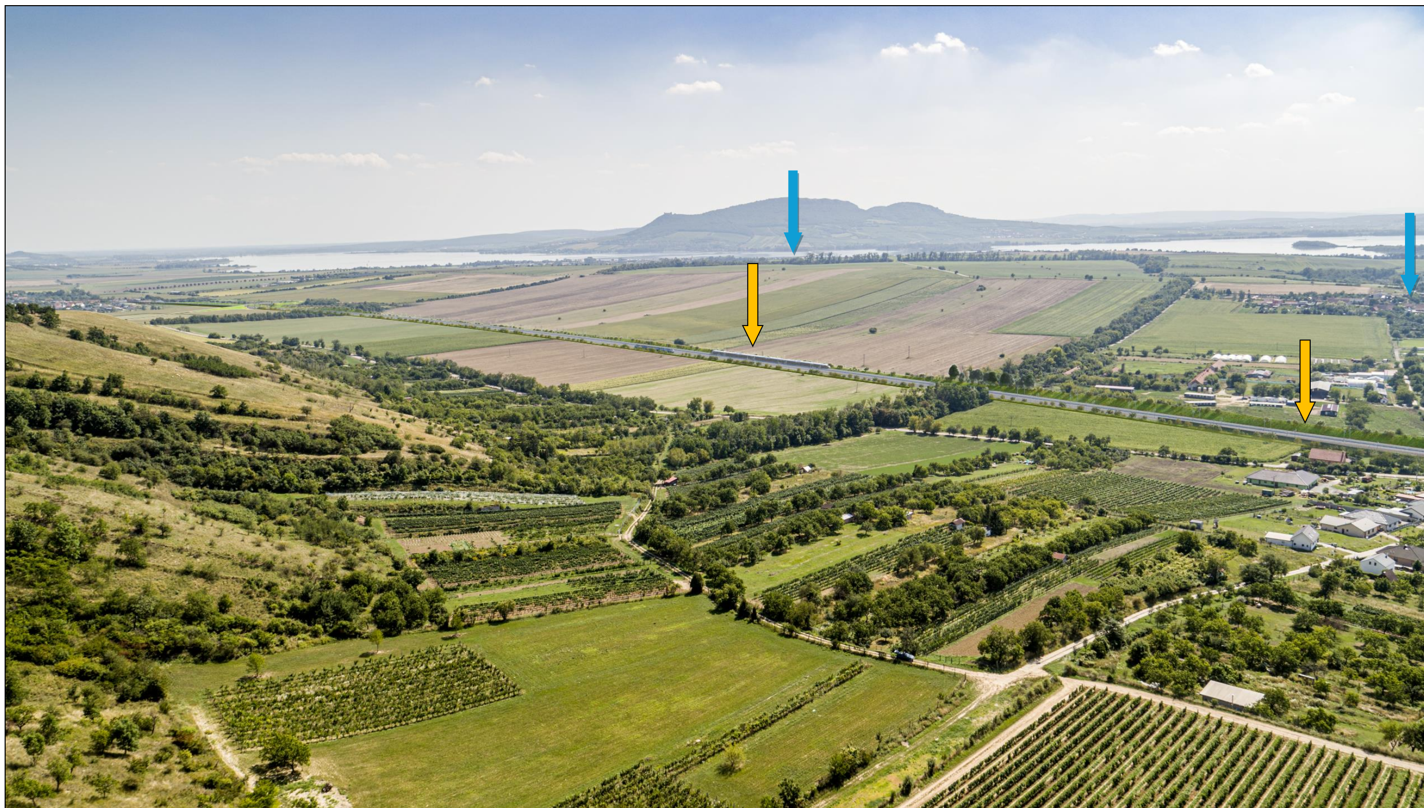
Obr. 89: Vizualizace záměru (zvýrazněna oranžovou šipkou, Valbek spol. s r. o., 2024) – Pohled ze vzduchu (z dronu) nad NPP Pouzdřanská step – Kolby/ vrchem Pouzdřanské stepy směrem na jihozápad na vedení trasy VRT v souběhu se stávající železnicí (oranžová šipka vlevo) v blízkosti obce Pouzdřany (modrá šipka vpravo), kde je směrem k obci uvažován ozeleněný a osázený zemní val (oranžová šipka vpravo); na snímku v popředí zřejmé vyšší zastoupení krajinné zeleně a plochy vinic a sadů, vpravo nepůvodní zástavba v podobě satelitů, za ní pak větší zemědělské objekty, v pozadí plocha vodní nádrže Nové Mlýny, za ní pak krajinná dominanta vrch Děvín (550 m n. m.) (modrá šipka vlevo)
