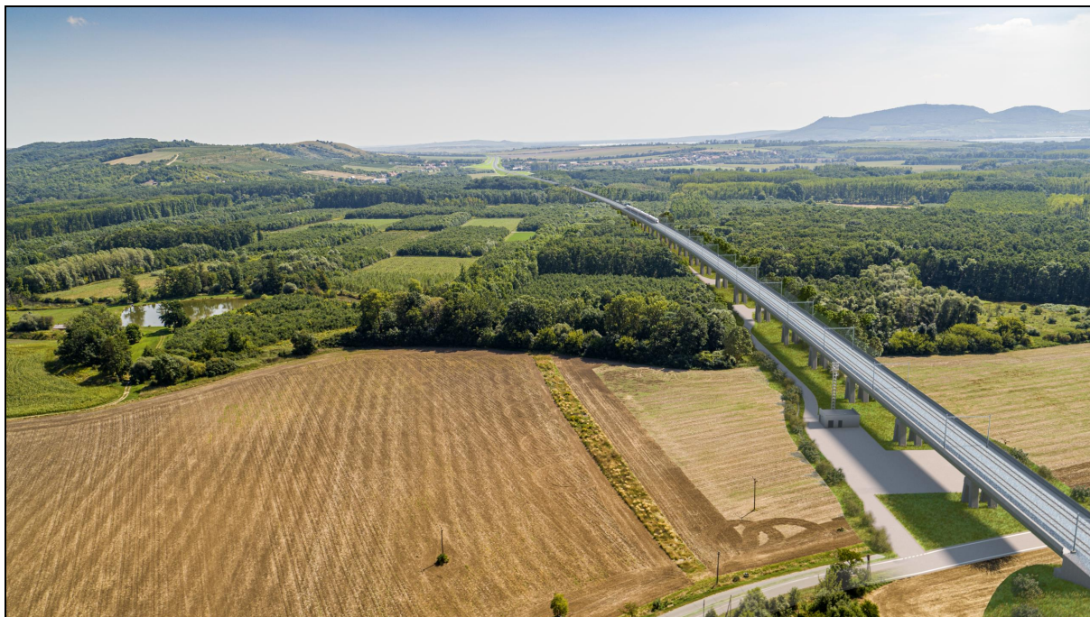
Obr. 98: Vizualizace estakády přes EVL Vranovický a Plačkův les v km 26,2-27,5 (Valbek spol. s r. o., 2024)
