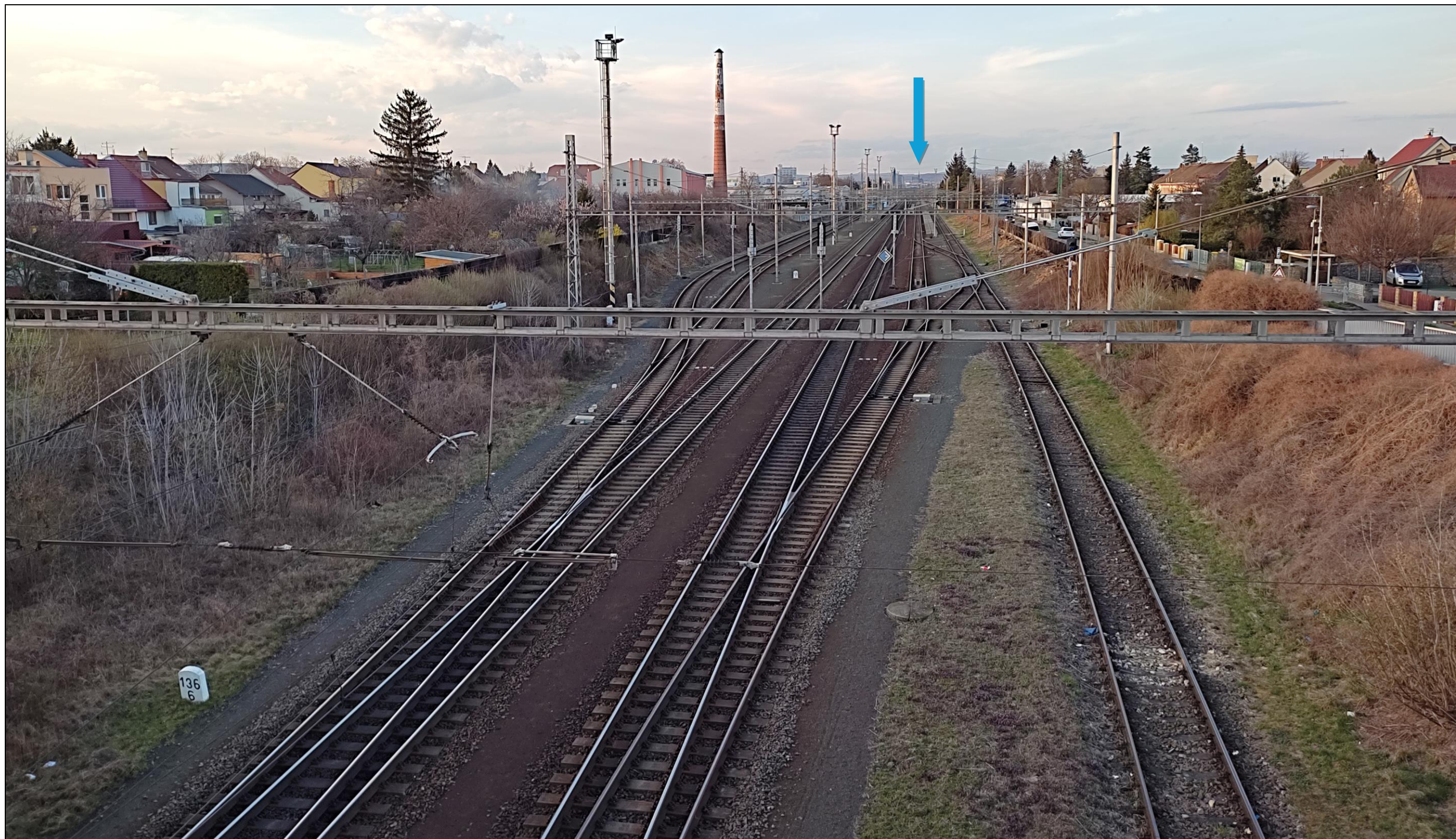
Obr. 67: Aktuální stav - Pohled z mostu propojující ulici Nádražní a Brněnskou (směrem na sever) na stávající železniční trať, resp. směrem na žst. Modřice; na obrázku v popředí zřejmé antropogenní prvky (komín, trakční vedení, stožáry VVN) s negativním projevem, v pozadí městská zástavba jižní části Brna a dále pak uprostřed kulturně historická dominantna centra Brna – Petrov (modrá šipka)
