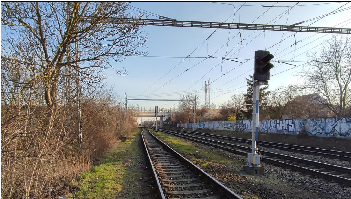
Obr. 50: Pohled na vedení stávající železniční trati v Modřicích, jak je zřejmé, vizuální projev trati do okolí je díky reliéfu a zástavbě minimální
