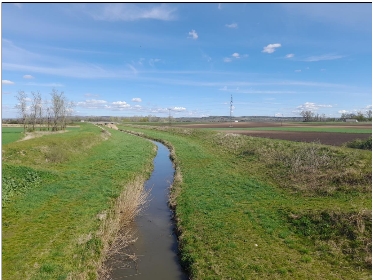
Obr. 35: Pohled ze silnice I/425 (východně od Rakvic) na upravené koryto Trkmanky, v místech křížení se silnicí I/425 a stávající železniční tratí; v pozadí těleso dálnice D2
