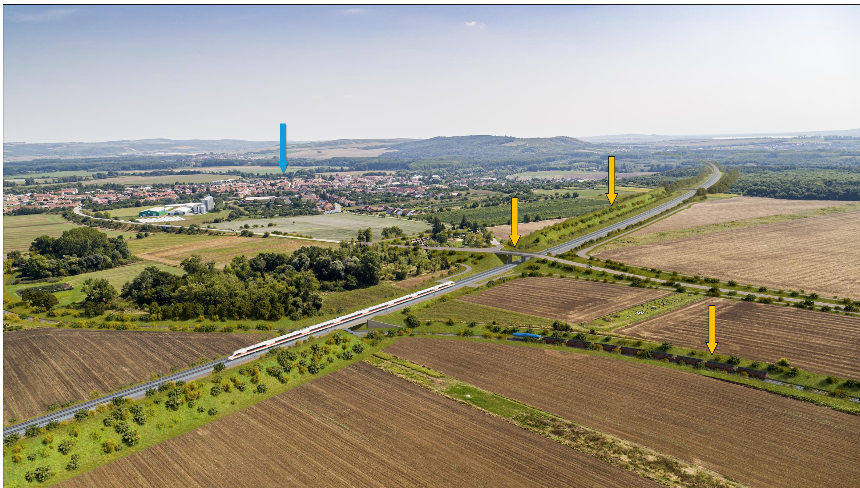
Obr. 85: Vizualizace záměru (zvýrazněna oranžovou šipkou, Valbek spol. s r. o., 2024) – Pohled ze vzduchu (z dronu) na trasu VRT v okolí Vranovic (modrá šipka), na snímku je zřejmé umístění nového zemního valu směrem k Vranovicím (oranžová šipka uprostřed) a upravená železniční vlečka Vranovice - Pohofelic (oranžová šipka vpravo), za ní je navržený most se silnicí a cyklostezkou; na snímku zřejmé vyšší zastoupení roztroušené krajinné zeleně a větších lesních porostů
