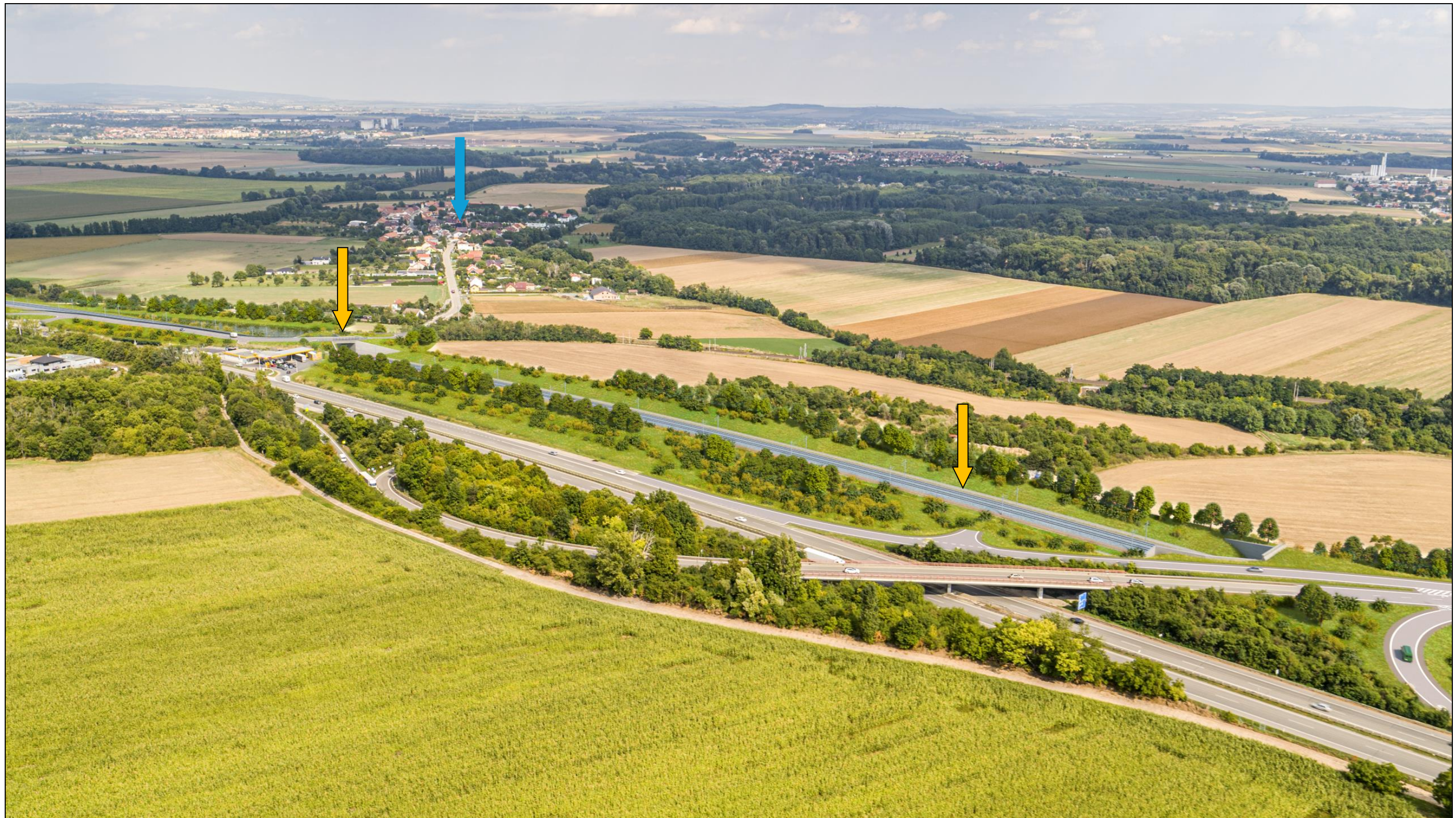
Obr. 77: Vizualizace záměru (zvýrazněna oranžovou šipkou, Valbek spol. s r. o., 2024) – Pohled ze vzduchu (z dronu) směrem od jihozápadu na vedení trasy VRT v blízkosti Popovic (modrá šipka) směrem k Rajhradu v souběhu se stávající D52; trasa VRT zde začíná zářezem klesat pod stávající terén a podchází silniční napojení města; v popředí vpravo lesní porost Popovický les (Bažantnice Rajhrad), za ním pak ve směru západ-východ údolí Bobravy – zřejmá zejména doprovodný a břehový porost kolem meandrujícího koryta
