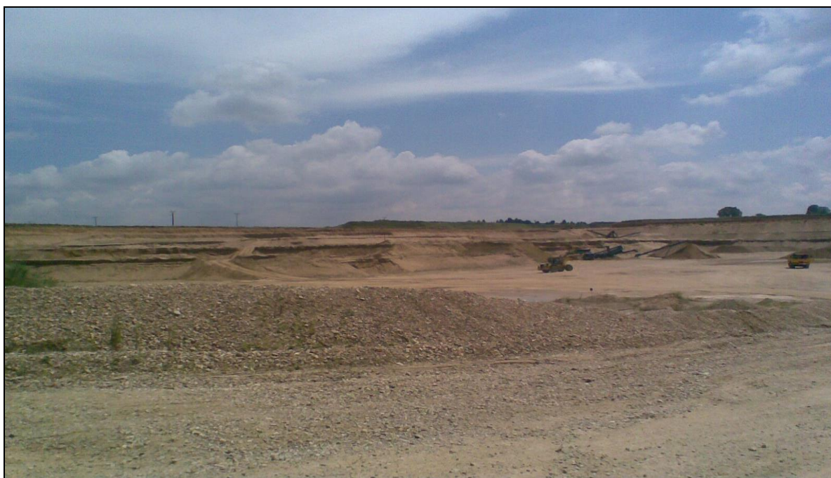
Obr. 25: Pohled na pískovnu v Hrušovanech u Brna
