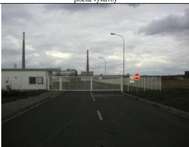
vjezd do zóny, plocha výstavby vpravo
