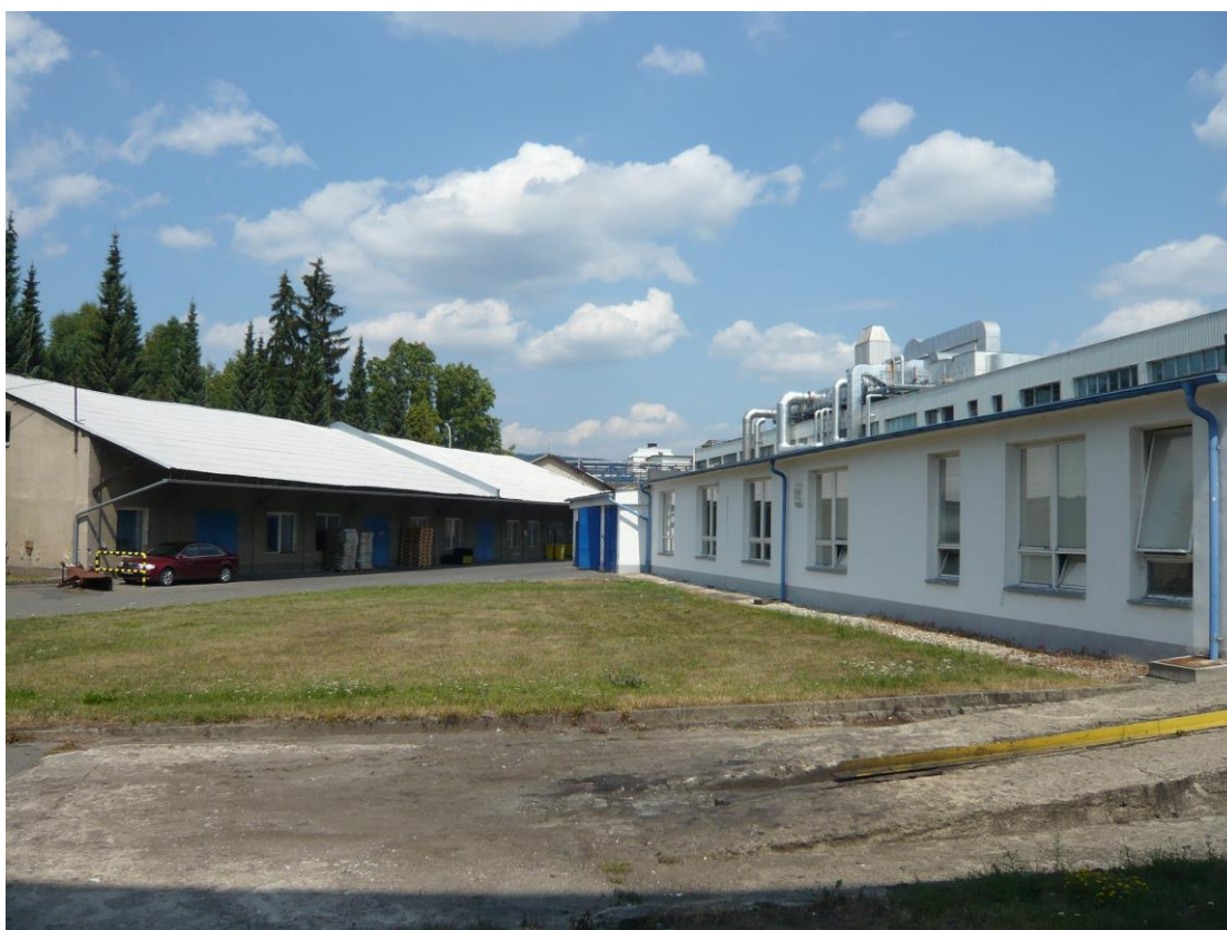
Obr. 2 Pohled severním směrem na lokalitu výstavby papírenského stroje PS6 a souvisejících objektů - SO 01 ÷ 04; objekty v levé části snímku budou před novou výstavbou odstraněny, zvažuje se nicméně i odstranění budovy na pravé straně (foto autor posudku, 05.08.2015)
