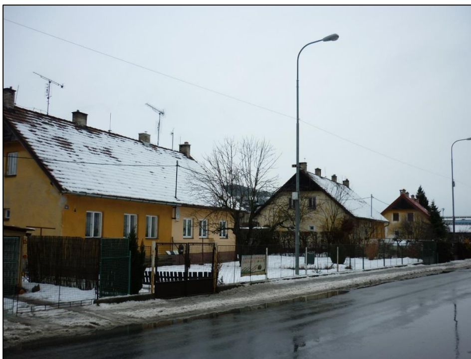
Obrázek 9: Obytná zástavba podél ulice U Tescomy
