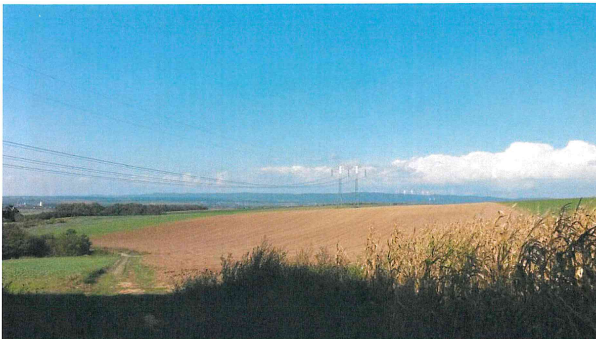
Přechod elektrovedu u Podolí (v popředí pozice stožáru č. 22)
