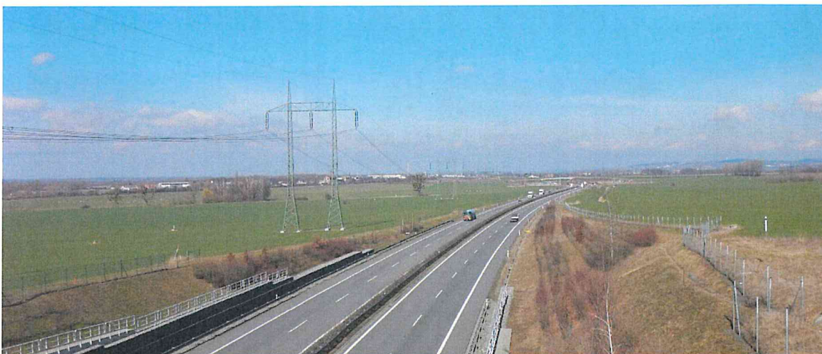
Vedení podél D55 – v pozadí Hulín (v popředí pozice stožáru č. 91)
