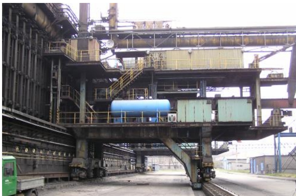
Obrázek B3: Strojní strana VKB 11 s výtlačným strojem
