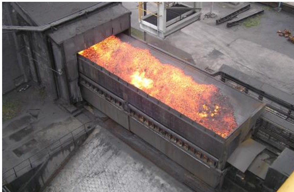
Obrázek B6: Vjezd hasícího vozu pod hasící věž
