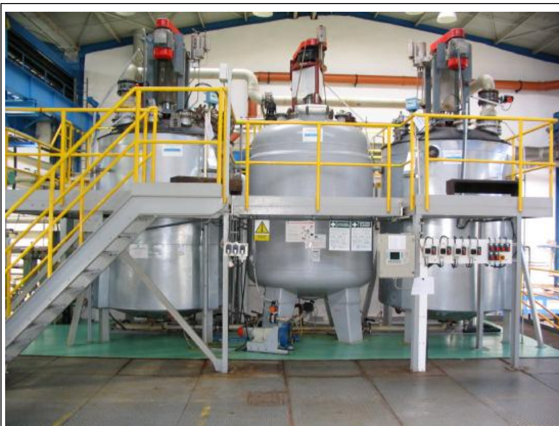
Stávající výrobní linka chloridu vápenatého - koncová část
