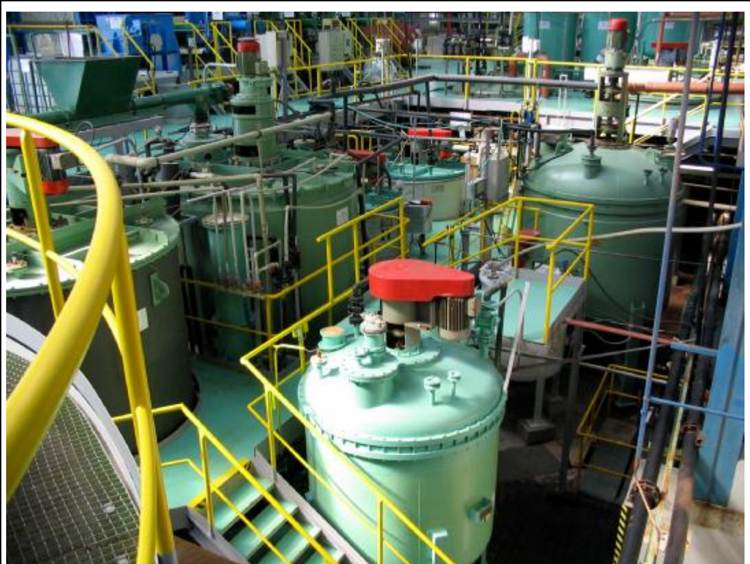
Stávající výrobní linka chloridu hořečnatého - loužení + karbonatace
