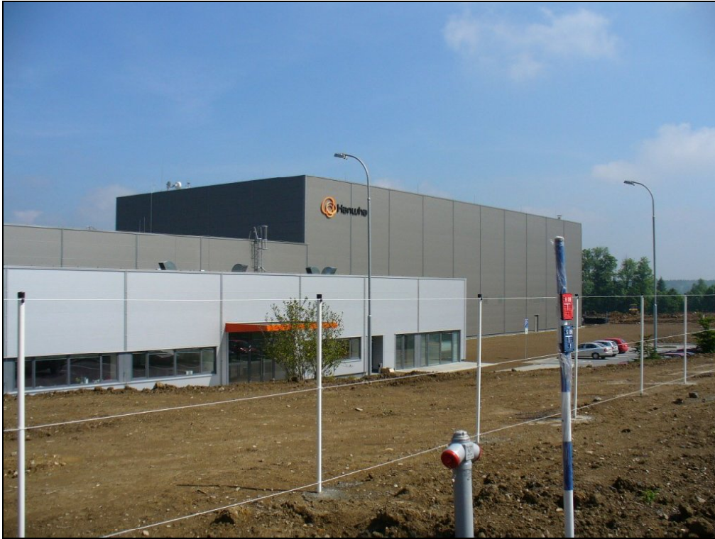
Stávající objekt výrobního závodu Hanwha, v popředí administrativní přístavek (pohled z jihozápadu)
