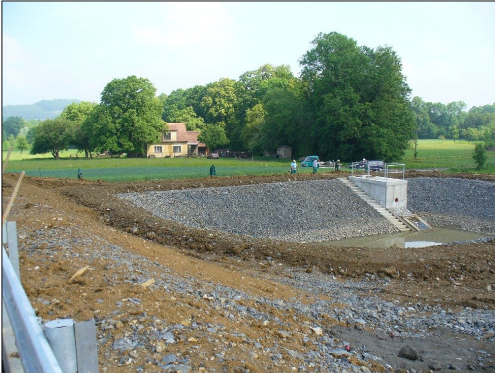
Retenční nádrž, v pozadí nejbližší obytná zástavba
