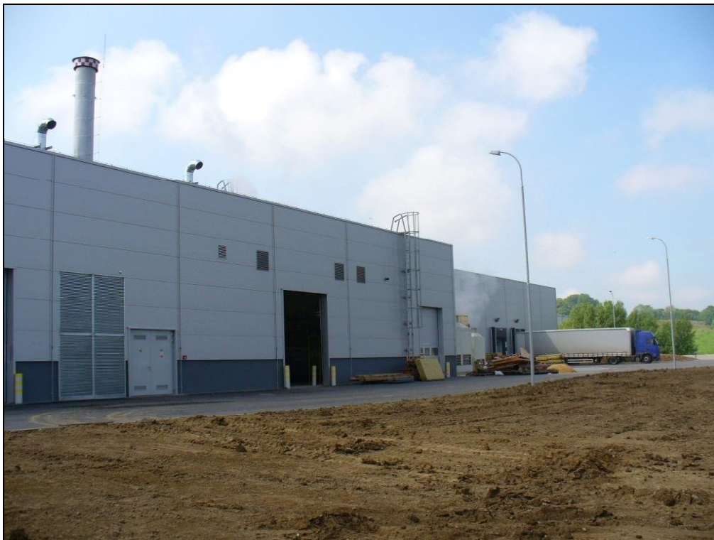
Pohled na stávající závod z místa výstavby nové výrobní haly (pohled ze severovýchodu)
