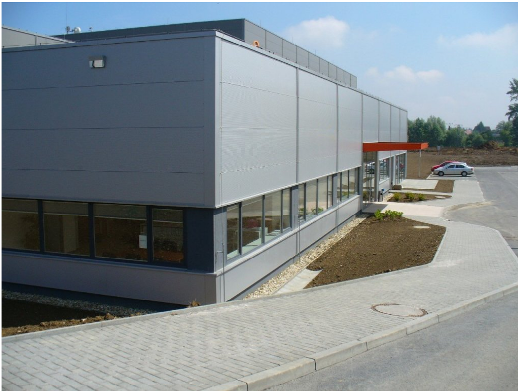
Stávající objekt výrobního závodu Hanwha, v popředí administrativní přístavek (pohled ze západu)
