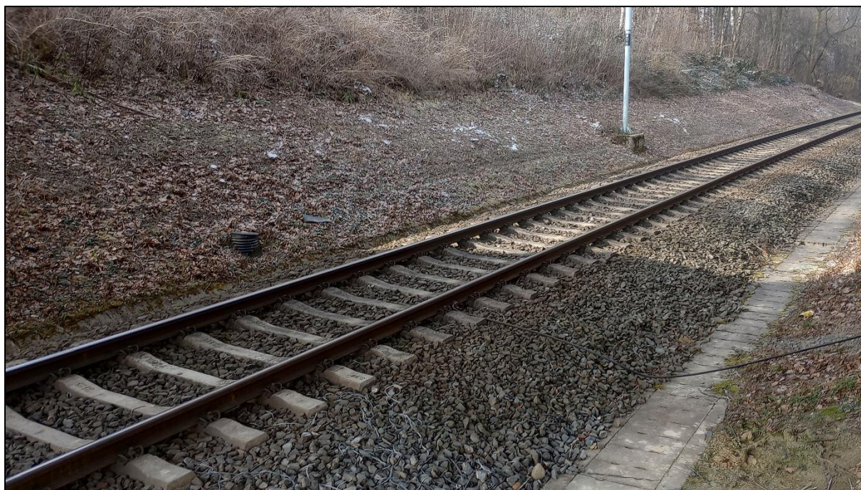
Obrázek 6 – Pohled na železniční trať č. 306A nedaleko měřicího místa M1
