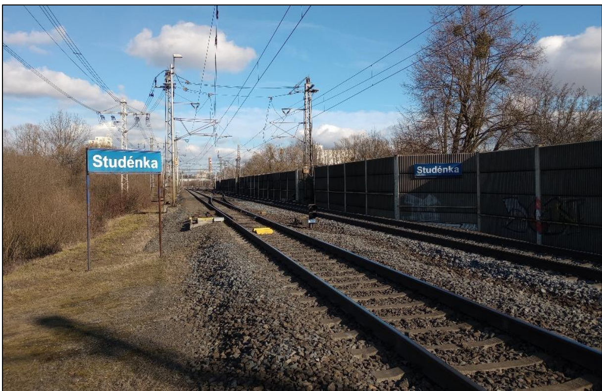
Obrázek 5 – Pohled na železniční trať č. 305B nedaleko měřicího místa M1
