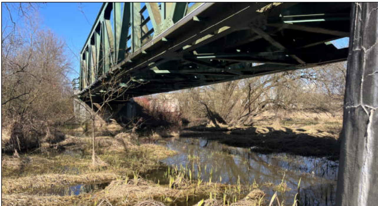
Obr. 3: Stávající mostní objekt přes Pustějovský potok (03/2025)
