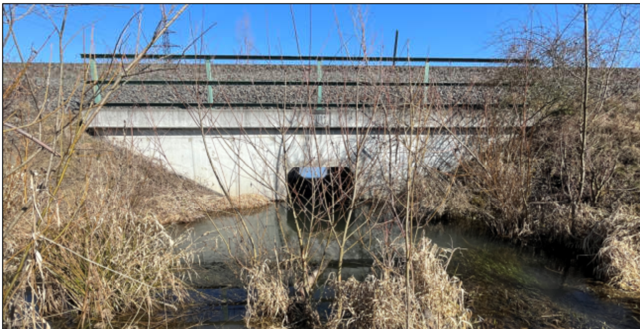
Obr. 4: Stávající stav propustek (03/2025)
