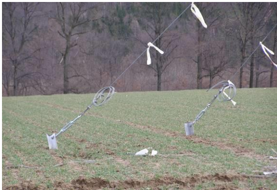
Obr.: Uchycení kotvících lan pomocí kotvících jehel (vlevo) nebo betonové kostky (vpravo)
