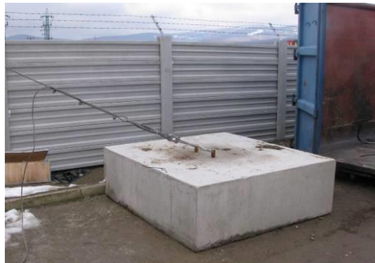
Obr.: Uchycení kotvících lan pomocí kotvících jehel (vlevo) nebo betonové kostky (vpravo)
