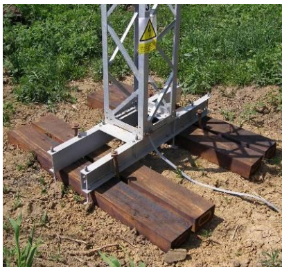
Obr.: Pražcový základ stožáru náhradní přenosové trasy
