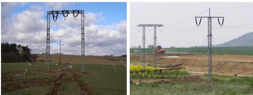
Obr.: Stožary náhradní přenosové trasy - portálový typ (vlevo) a jednodřívkový typ (vpravo)
