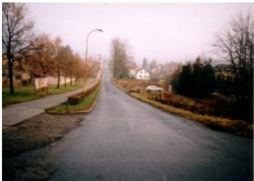
Ulice V aleji od křižovatky s Pražskou ulicí vpravo staveniště prodejny
