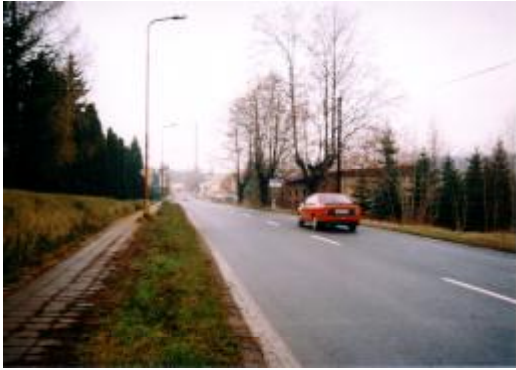
Pražská ulice - vpravo zařízení nefunkční ČOV
