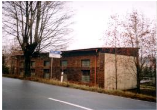
ČOV v prostoru staveniště prodejny PLUS DISKONT
