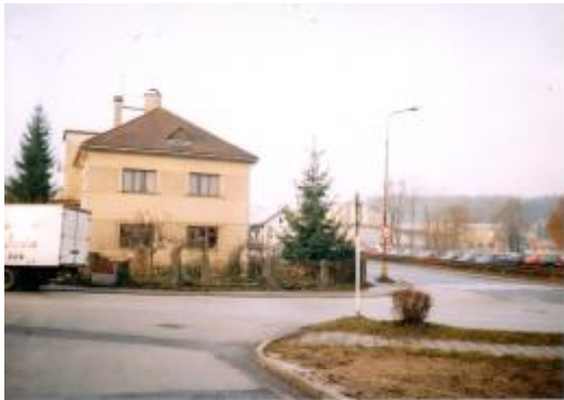
Obytný dům p.č.1914 s prodejnou na křižovatce Pražské, V aleji a U studénky
