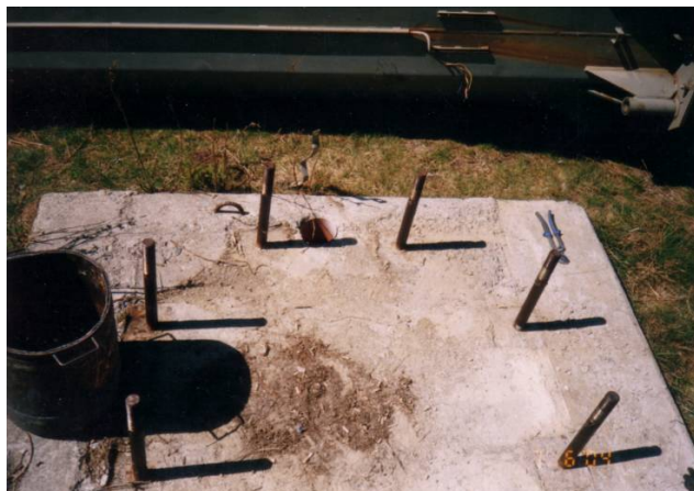
Základ sloupu SLD
