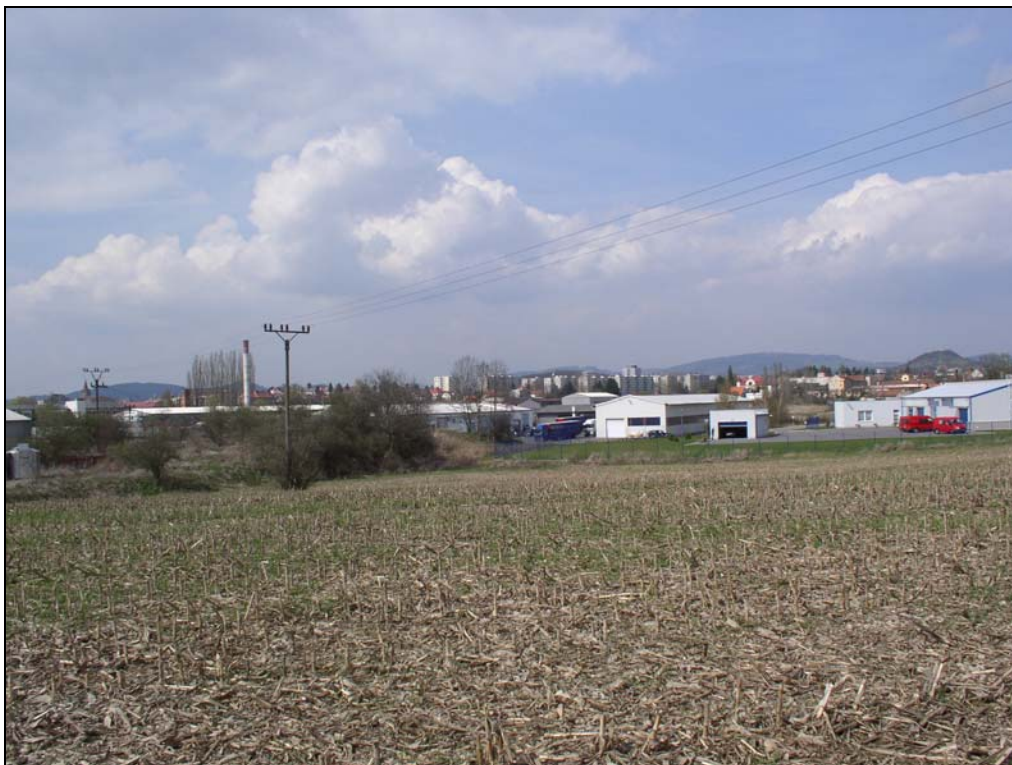
obrázek 4: Pohled na plochu výstavby k S
