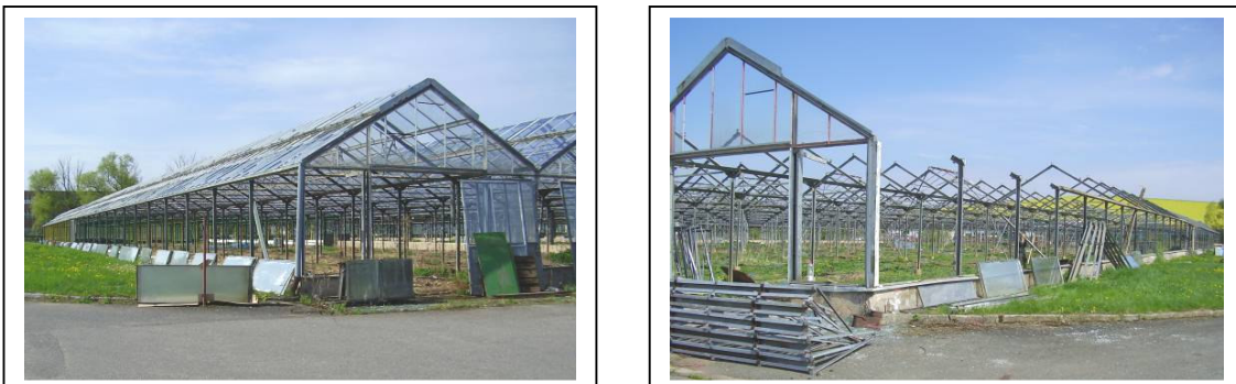
Obrázek č. 2: Odstraňování stávajících skleníků ve východní části areálu
