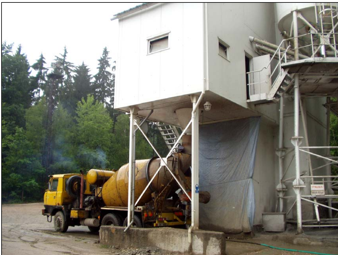
Pohled na provoz mísícího jádra, dopravník a venkovní skládky kameniva
