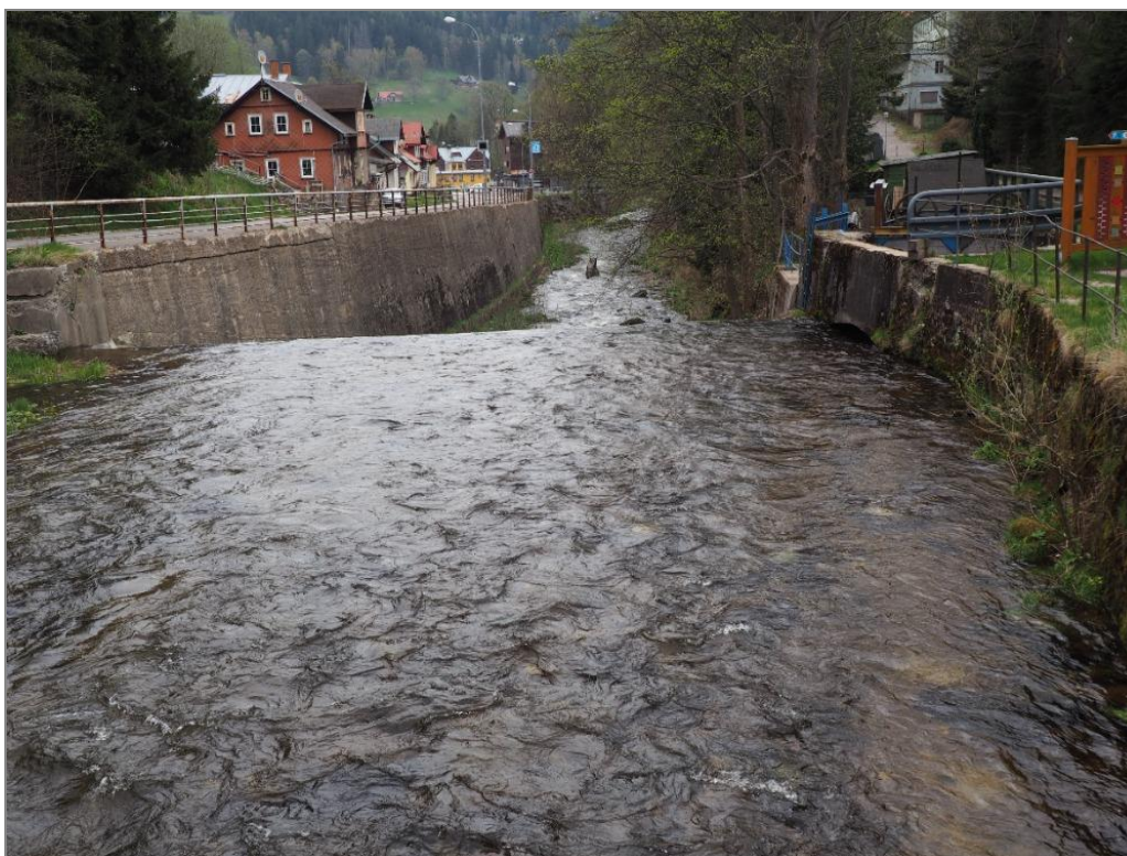
Jez ve Velké Úpě a prostor úprav opěrné zdi SO 251
