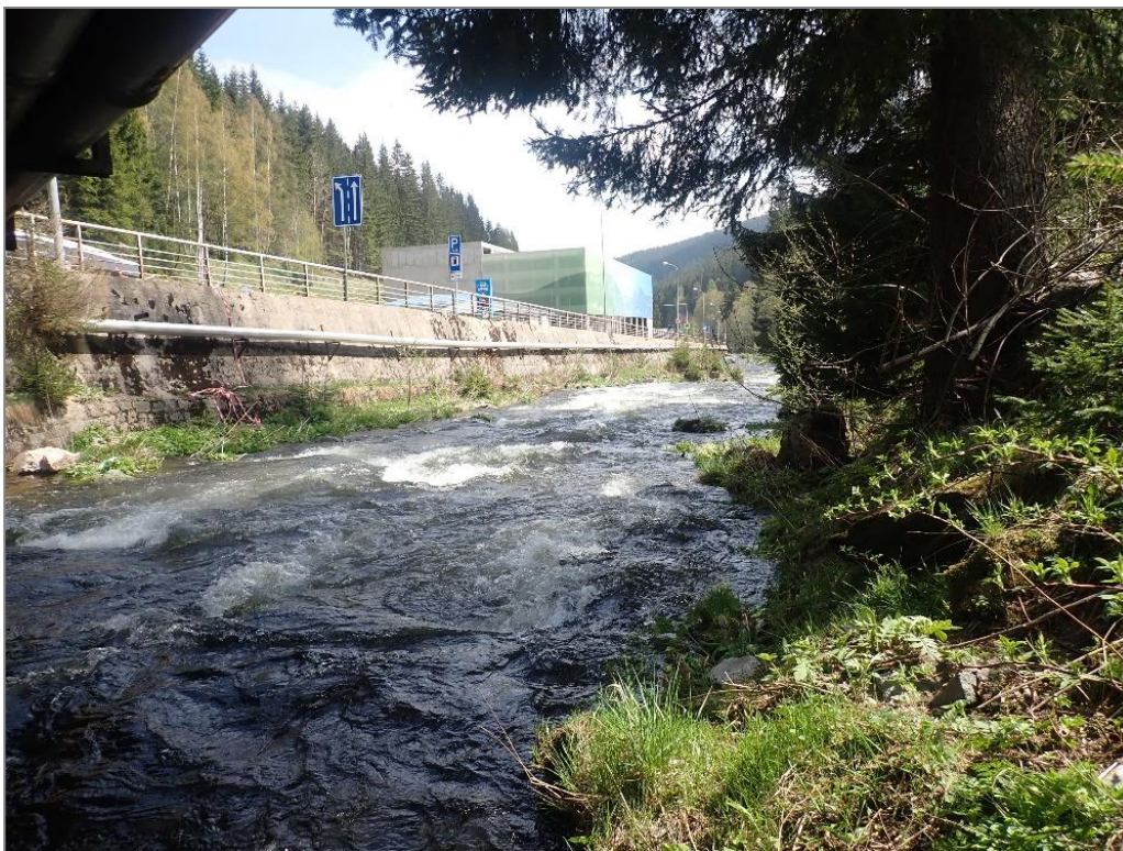
Opěrná zeď u Parkovacího domu SO 253.
