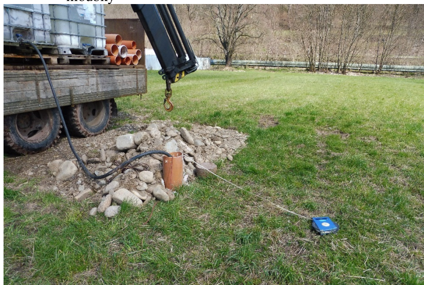
Foto č. 3: Vsakovací zkouška v sondě HGS-1 dne 19.4.2023
