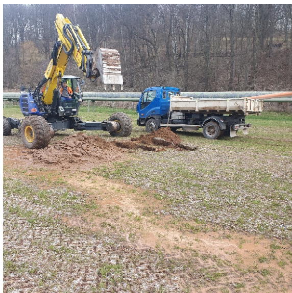
Foto č. 4: Hloubení průzkumné hydrogeologické sondy HGS-2
