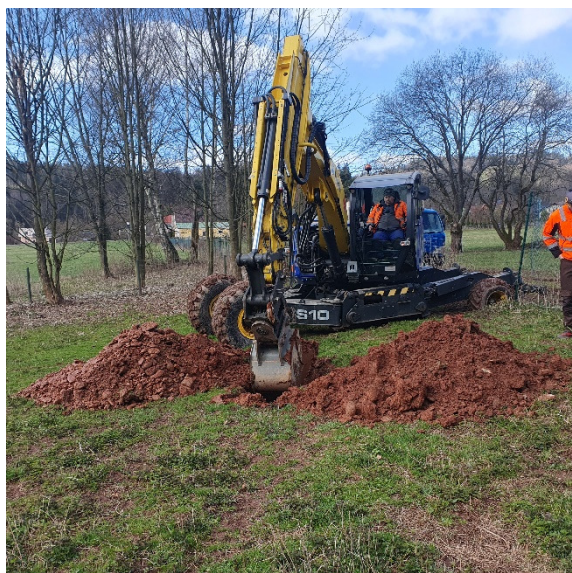
Foto č. 10: Hloubení průzkumné hydrogeologické sondy HGS-5 dne 4.4.2023
