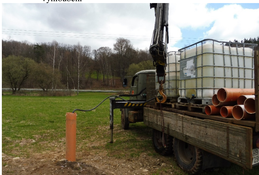
Foto č. 8: Vsakovací zkouška v sondě HGS-3 dne 19.4.2023
