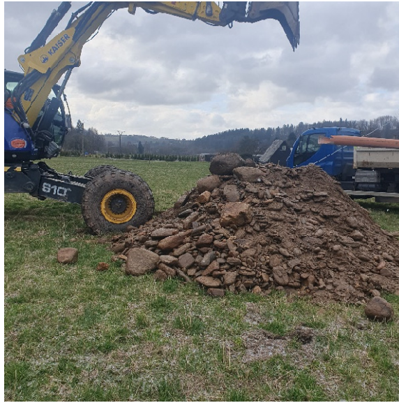
Foto č. 1: Hloubení průzkumné hydrogeologické sondy HGS-1 kolovým rypadlem dne 4.4.2023
