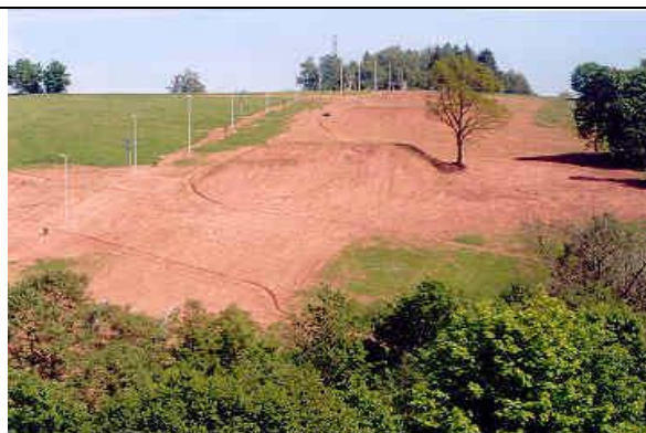
Areál snowparku, patrný ponechaný dub letní (ale s přisypáním kmene a poškozením kořenů)
